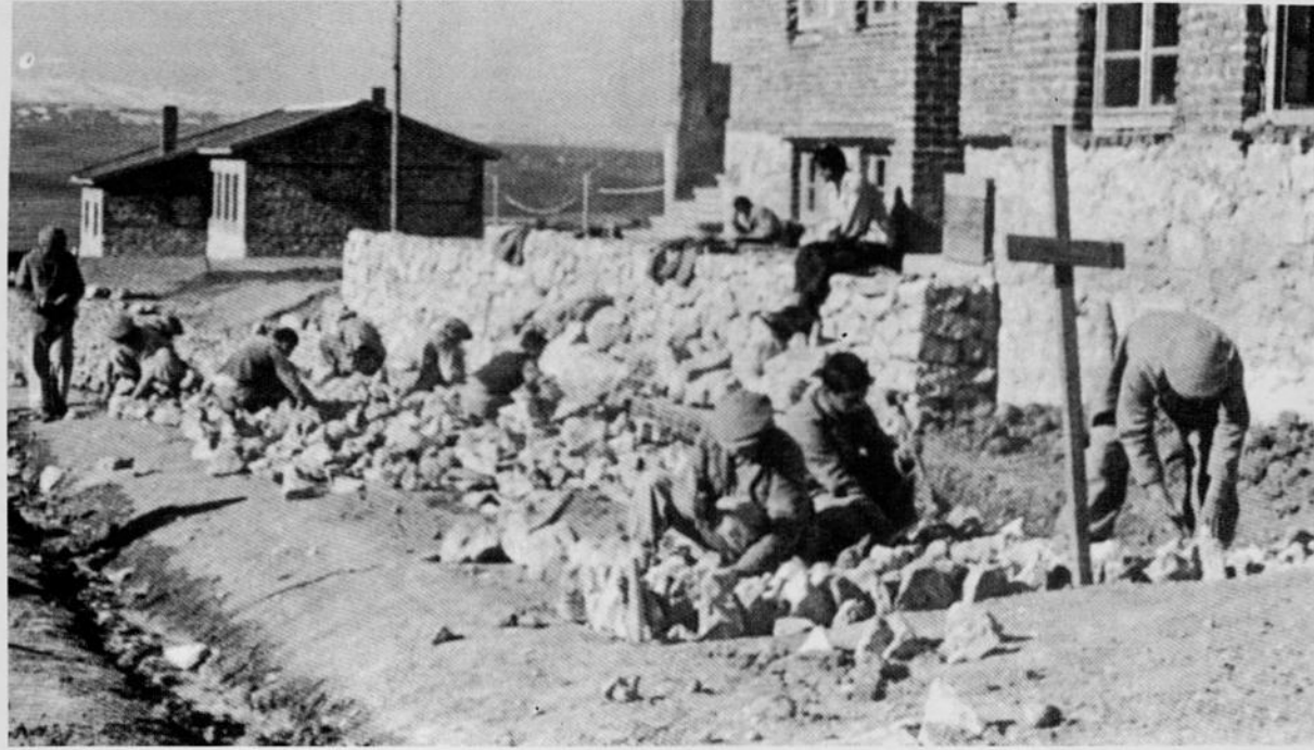
27,28,29-Hasanoğlan Köy Enstitüsü'nde öğrencilerin yol yapım çalışmaları
