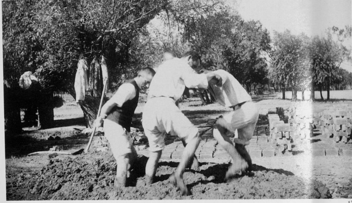
13,14,15- Kastamonu Gölköy Köy Enstitüsü binalarının yapımı için tuğla üretilmesi
