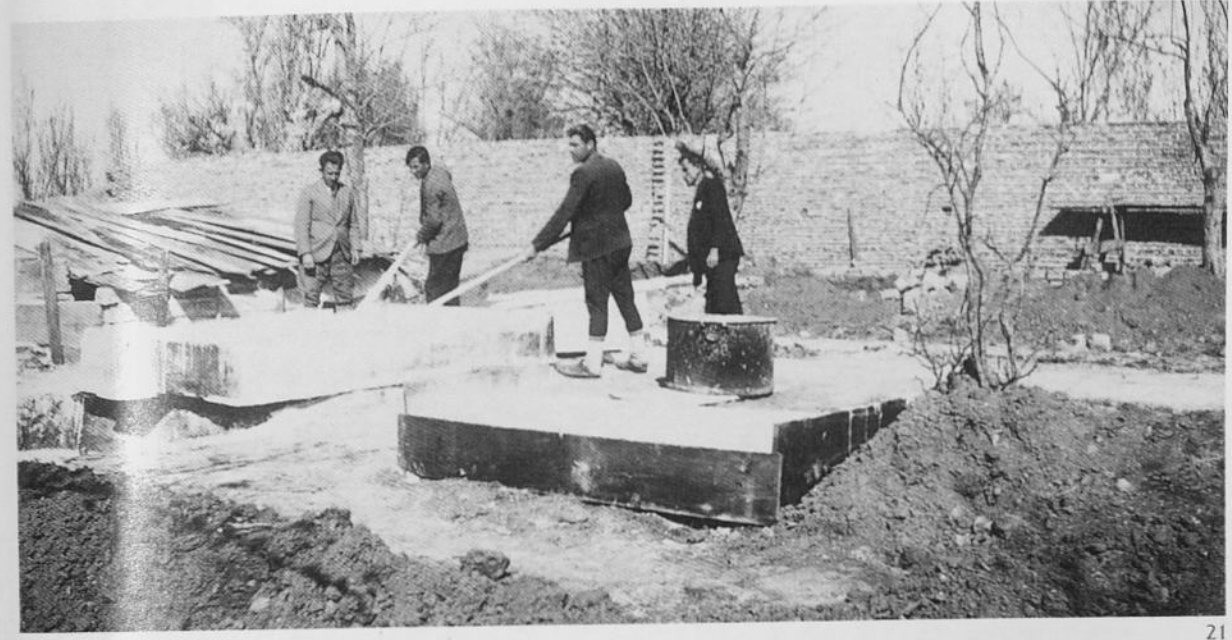
21,22,23- Kireç eri- tilmesi ve harç yapılması
