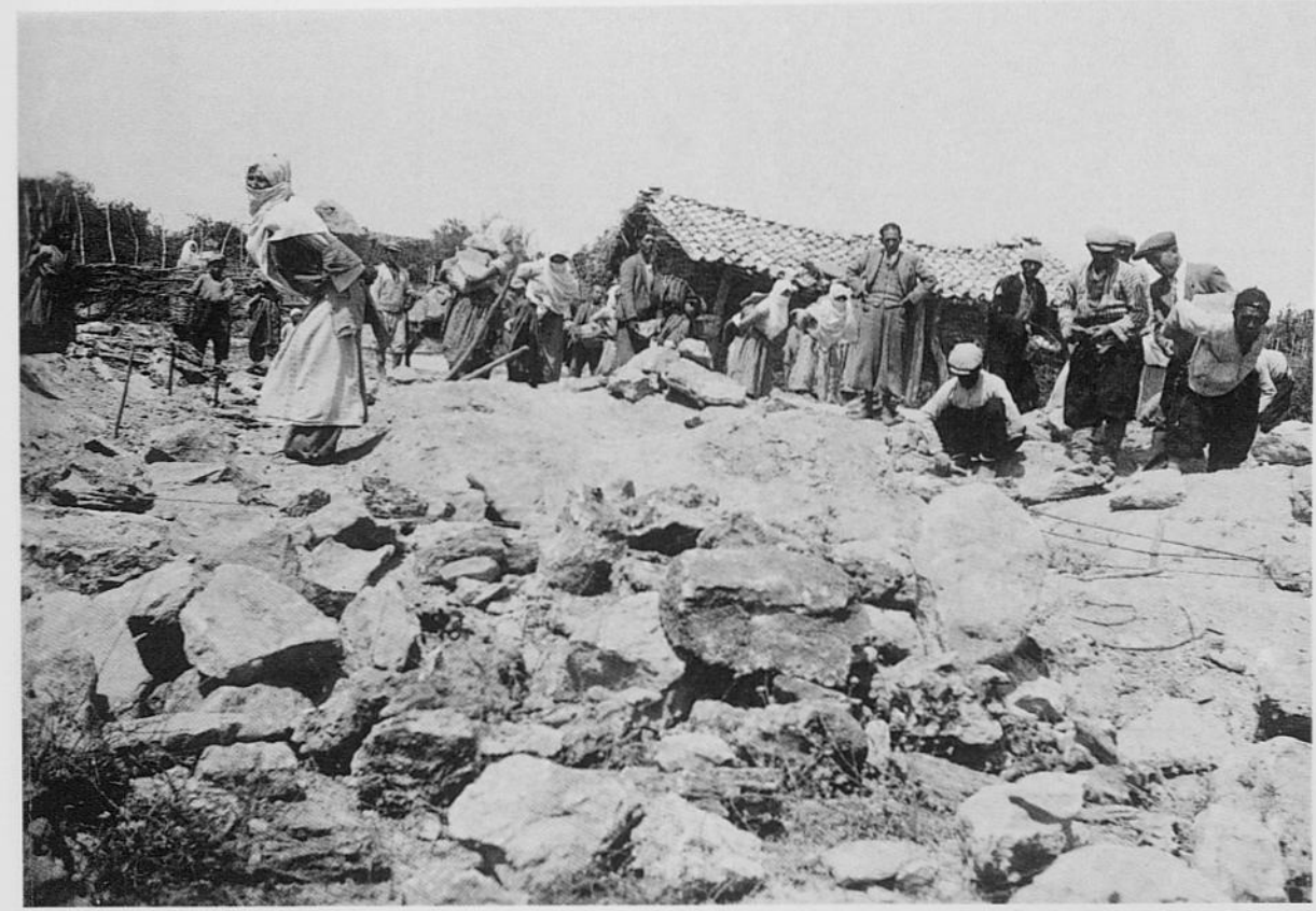
3,4- Manavgat Çengel Köyü İlkokulu inşaatına taş taşıyan köylüler
