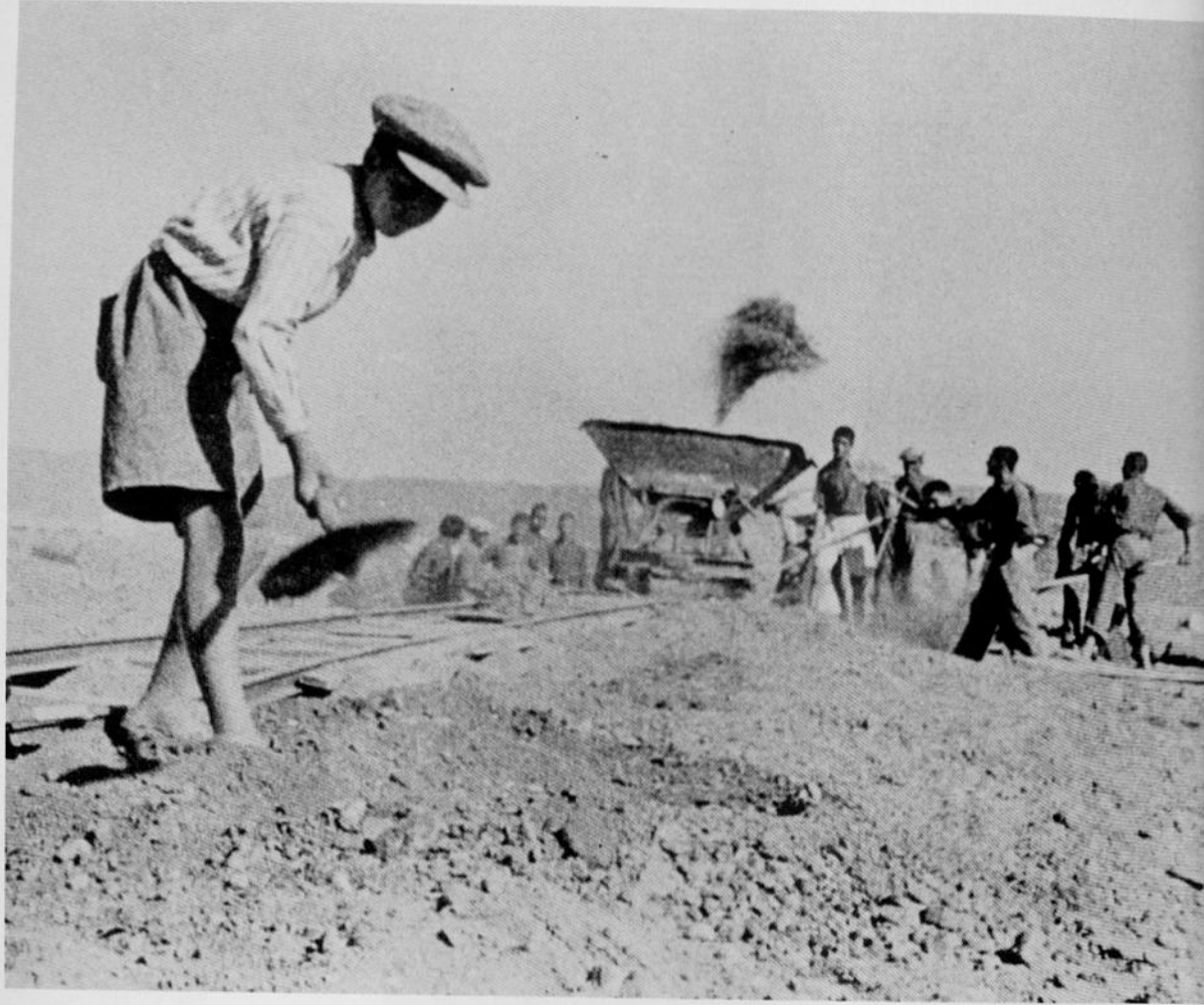
16,17- Raylar üzerinde toprak nakli
