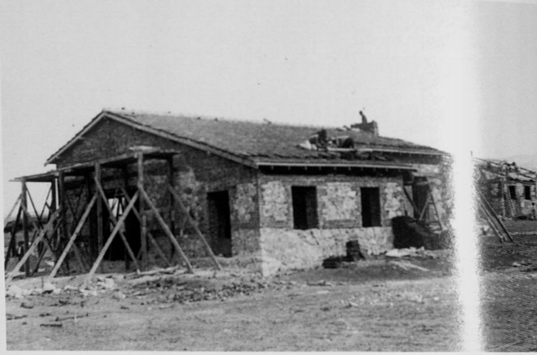
48- Hasanoğlan Köy Enstitüsü atölye inşaatı 49,50- Kepirtepe Köy Enstitüsü inşaatı 51- İnşaatla başla çalışan öğrenciler
