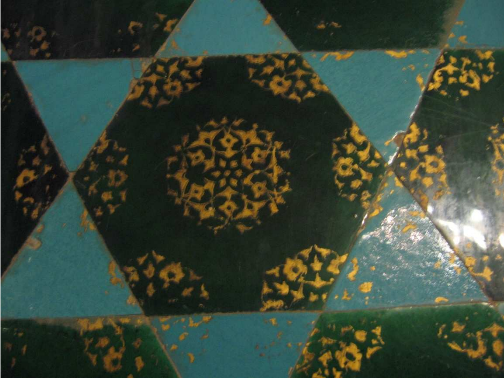
Resim 63: Bursa Yeşil Cami, doğu eyvanın duvarlarından detay. (21.10.2009).
