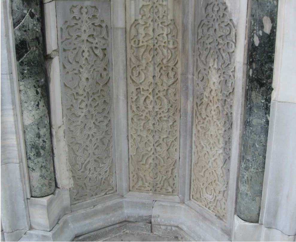
Resim 10: Bursa Yeşil Cami ön cephe batı mihraptan detay (21.09.2009).
