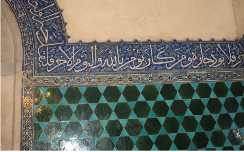
Resim 62: Bursa Yeşil Cami, doğu eyvanın duvarlarından detay. (21.10.2009).
