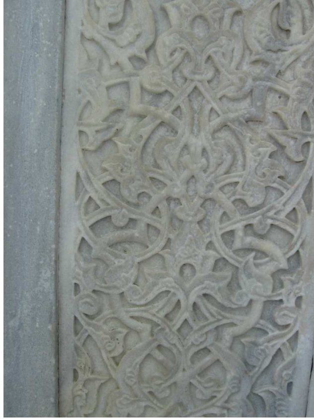
Resim 11: Bursa Yeşil Cami ön cephe batı mihraptan detay (21.09.2009).
