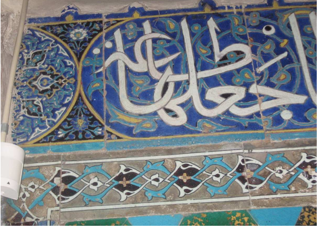
Resim 64: Bursa Yeşil Cami, doğu eyvanın duvarlarından detay. (21.10.2009).
