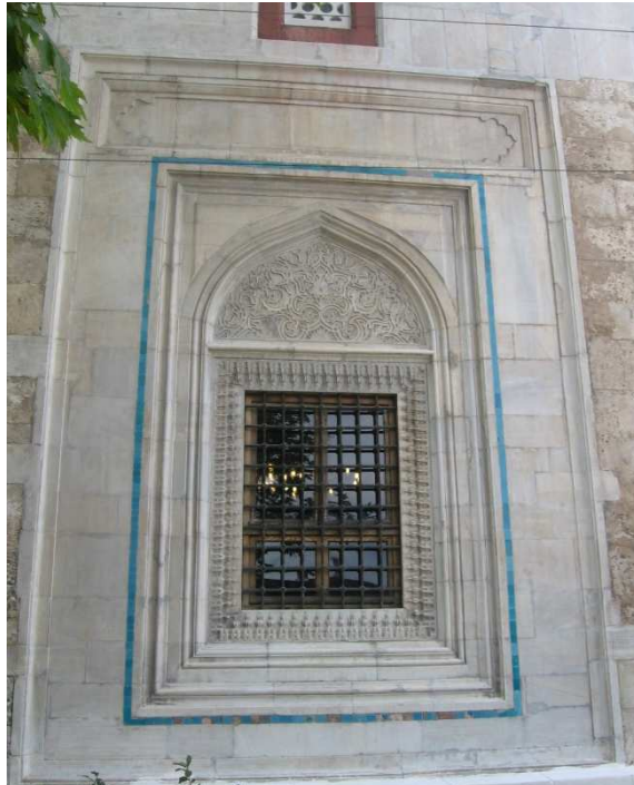
Resim 142: Bursa Yeşil Cami, batı cephesindeki pencere kenarlarındaki çiniler.
