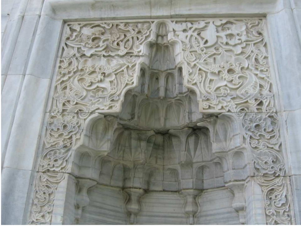
Resim 09: Bursa Yeşil Cami ön cephe batı mihraptan detay (21.09.2009).
