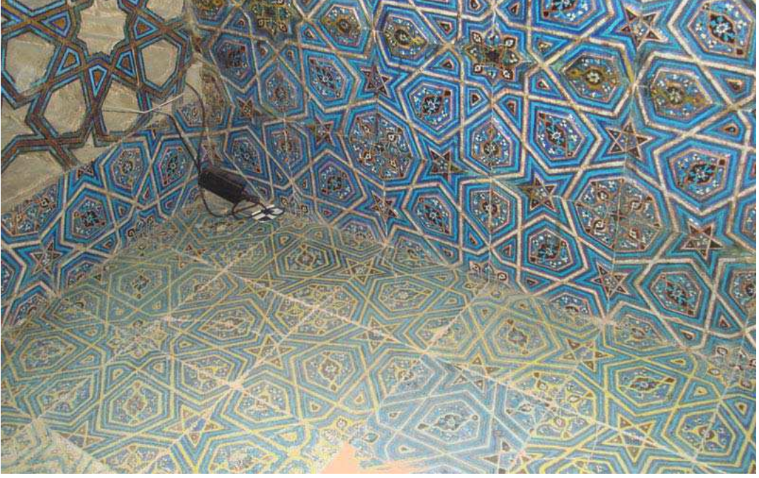
Resim 119: Bursa Yeşil Cami, hünkâr mahfilinin duvar ve zemin çinilerinden görünüm. (21.10.2009).
