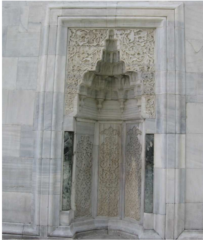
Resim 08: Bursa Yeşil Cami ön cephe batı mihraptan görünüş (21.09.2009).
