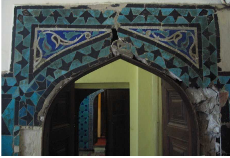
Resim 139: Bursa Yeşil Cami, balkonun kapı alınlığı çinileri.
