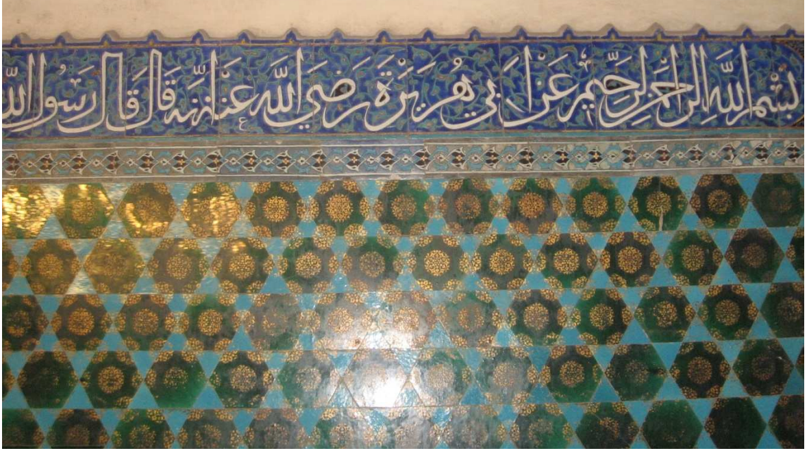
Resim 66: Bursa Yeşil Cami, doğu eyvanın duvarlarından detay. (21.10.2009).
