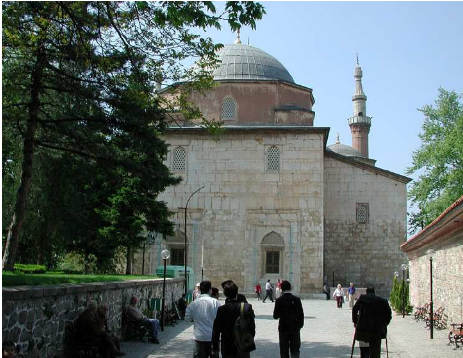
Resim 21: Bursa Yeşil Cami güney cephesi genel görünüşü (21.09.2009).
