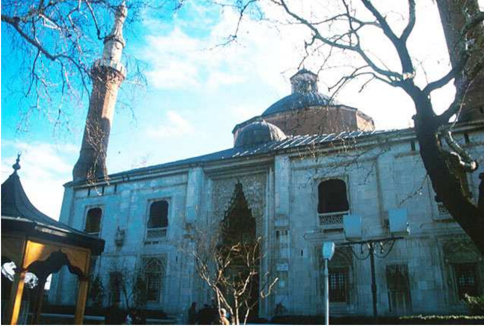
Resim 01: Bursa Yeşil Cami ön cepheden görünüş (arcnet.com 01.06.2009).
