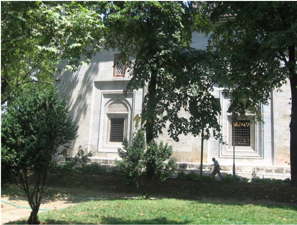
Resim 19: Bursa Yeşil Cami batı cephesi genel görünüş (21.09.2009).
