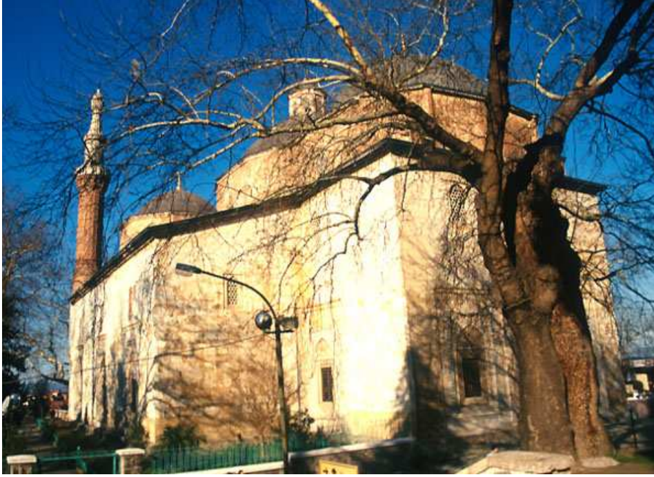
Resim 20: Bursa Yeşil Cami güney batı cephesi genel görünüşü (21.09.2009).
