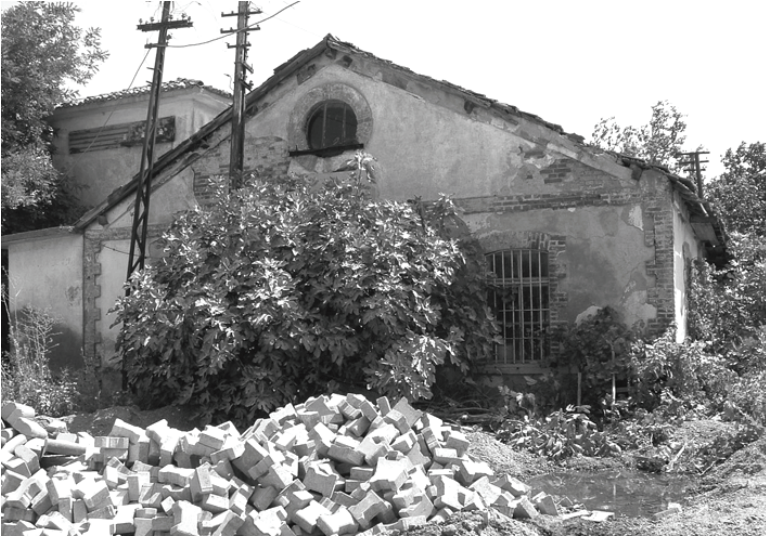
Çanakkale Eski Su Deposu (82)
