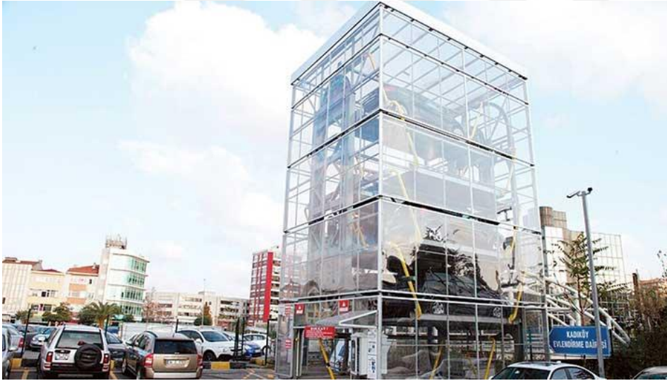
Şekil 22. Dönme dolap otopark örneği (Kadıköy)
