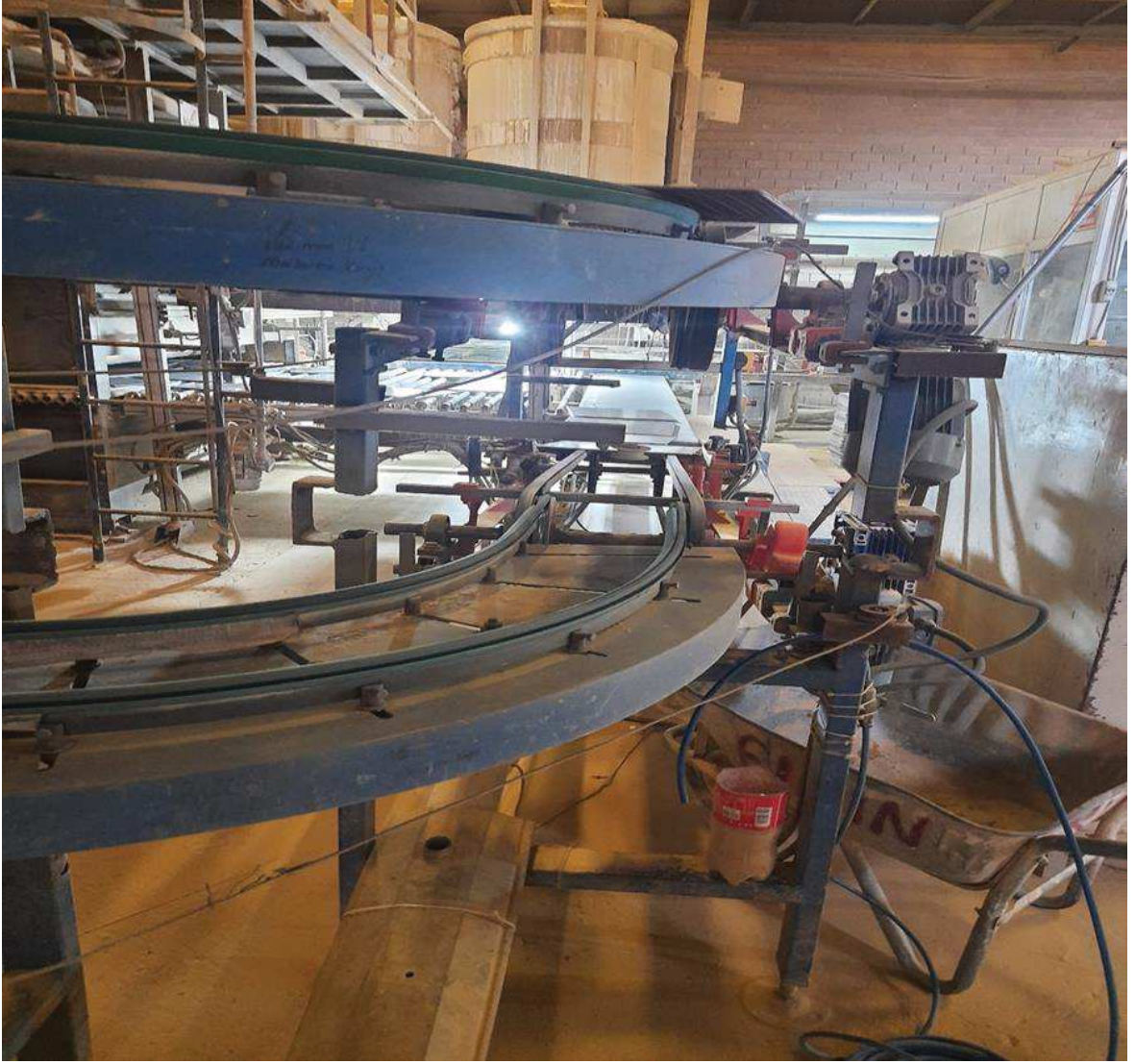
Şekil 25 Acil butonlarının, tellerinin, sensörlerin olmaması ve çalışmaması
