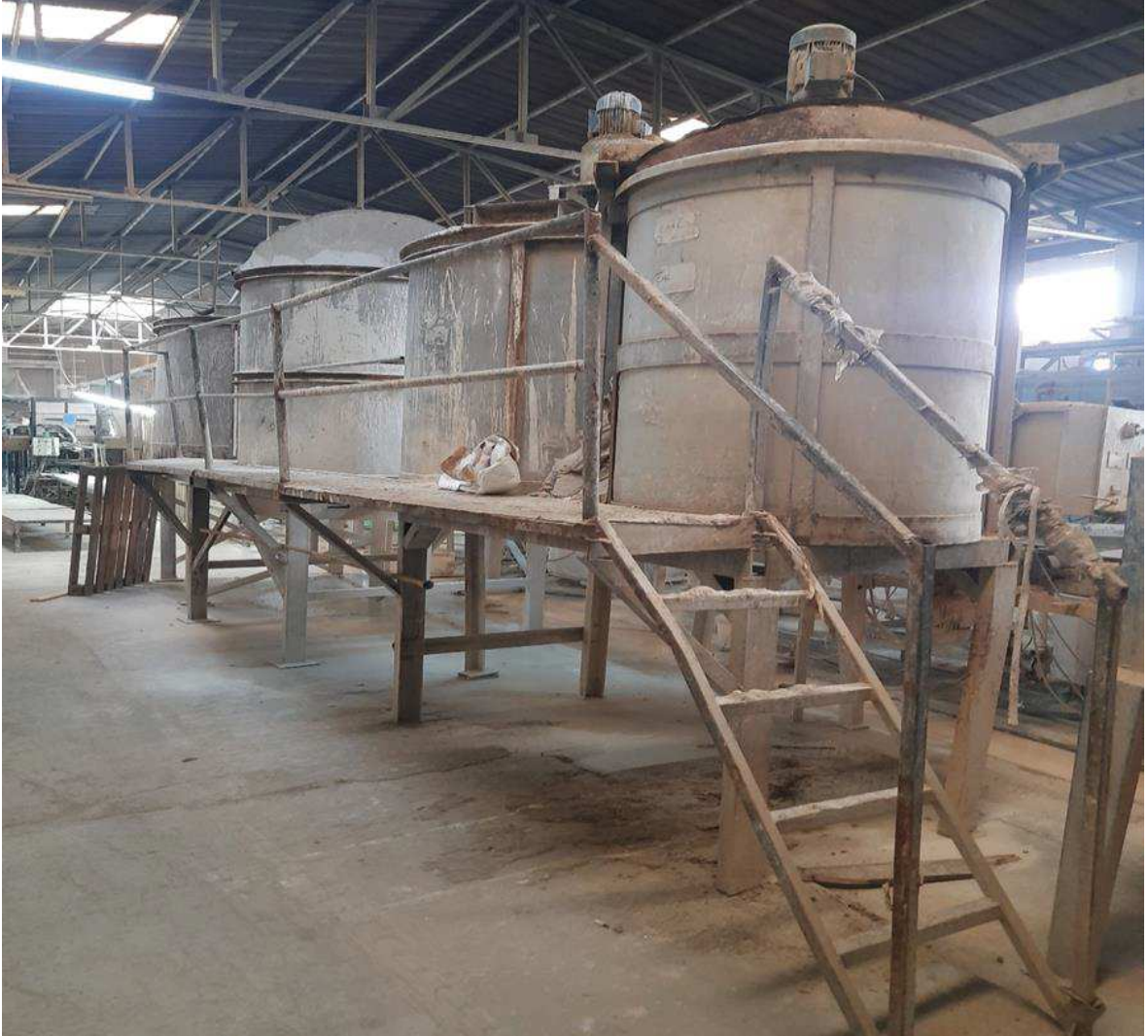
Şekil 21 Sır tanklarının temizlenmesi
