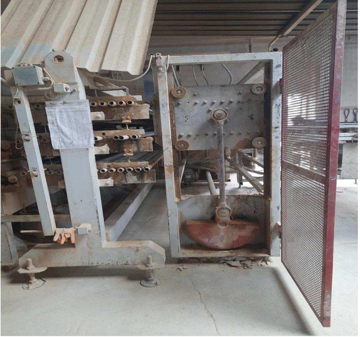
Şekil 26 Yükleme/boşaltma makinelerinin asansörlerinin mekanik muhafazalarının açık bırakılması
