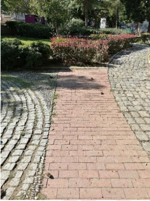
řekil 68. Kp tař, podima, taban tuđlası ve arnavut tař dřeme detayı (Orijinal, 2022)
