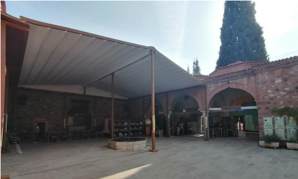
Şekil 82. Avluda bulunan örtü elemanı (Orijinal, 2021)
