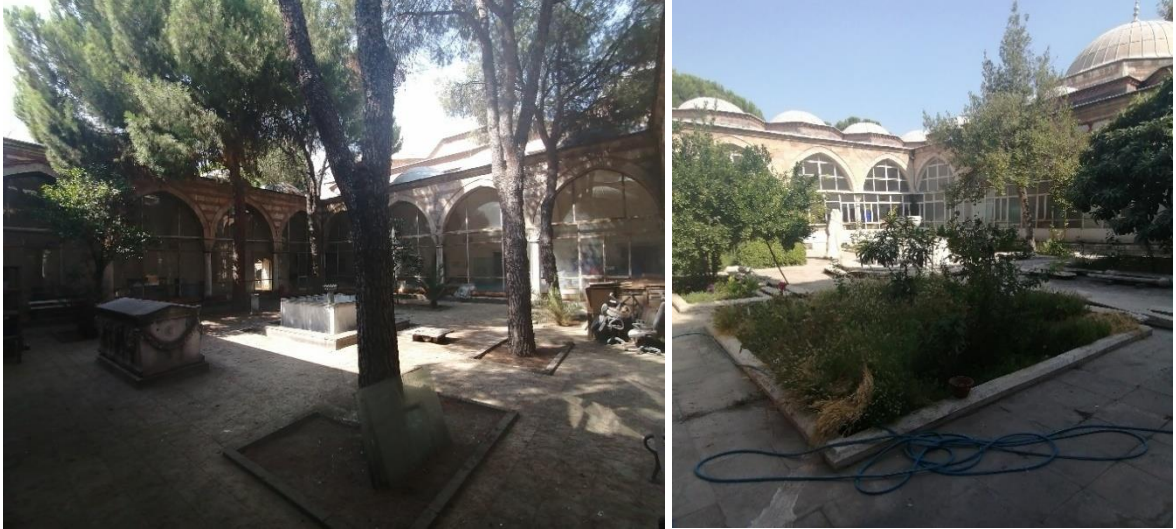
Şekil 100. İmaret binası ve medrese avlularının genel görünümü (Orijinal, 2022)
