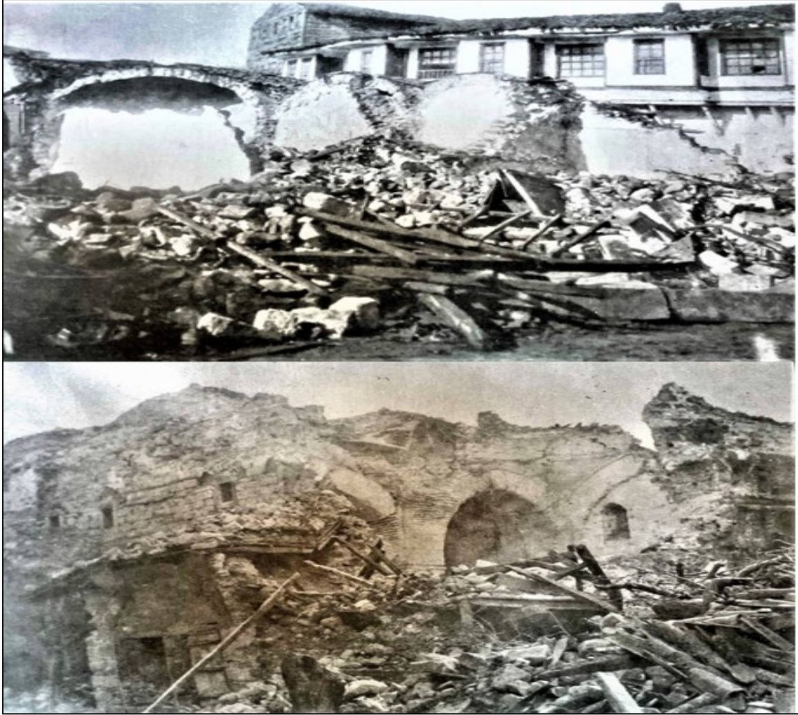
Şekil 8. Balıkesir'de 1898 yılında meydana gelen deprem sonrası oluşan yıkımlar (Balıkesir Kent Arşivi Koleksiyonu, 2013)
