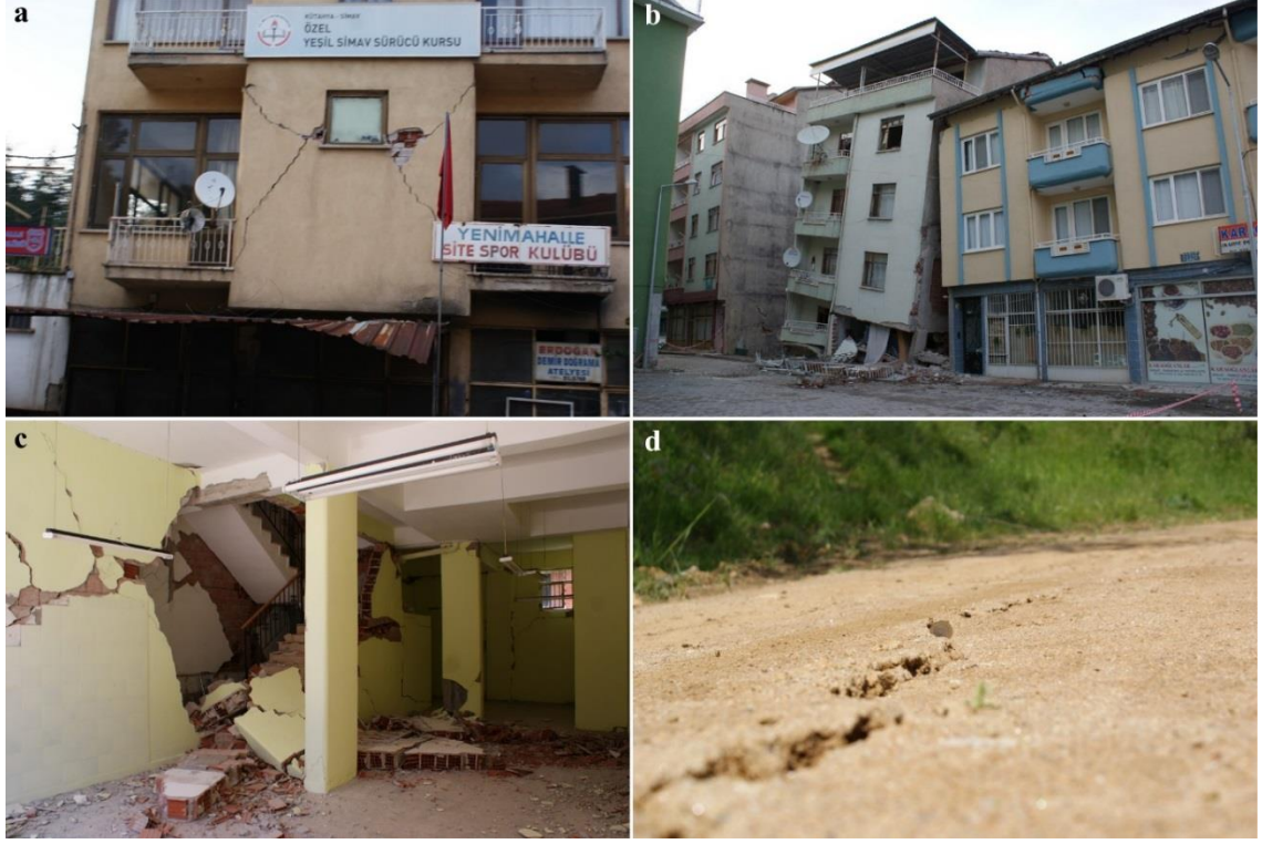
Şekil 4.36. Simav depremi sonrası meydana gelen yapısal hasarlar (a, b, c) ve yüzey çatlakları (d)
