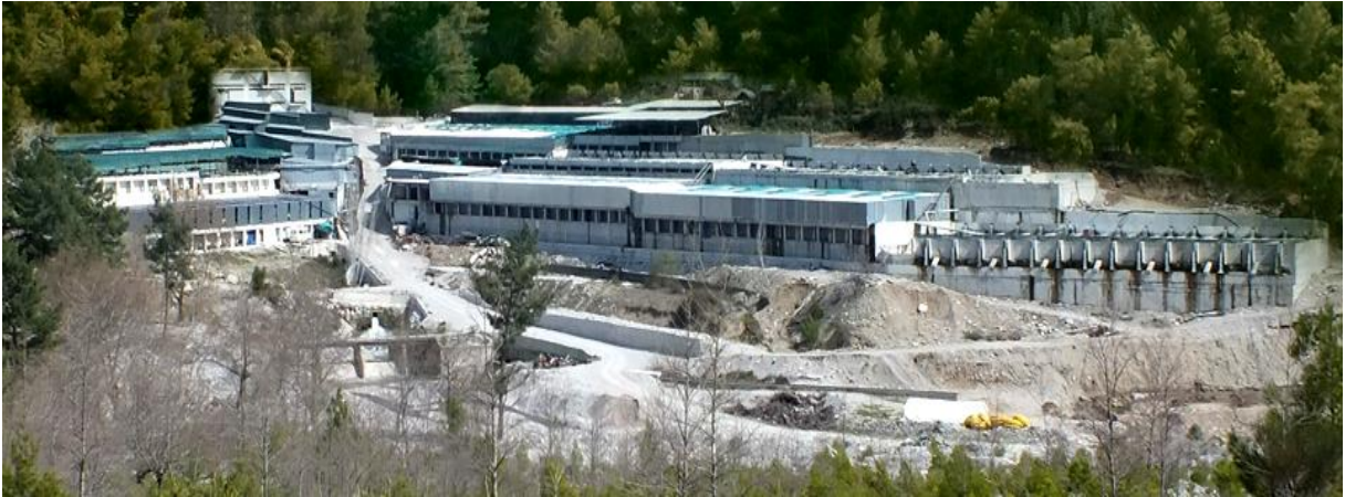
Şekil 3.2. Fethiye Çobanlar Söğütlüdere Tesisi
