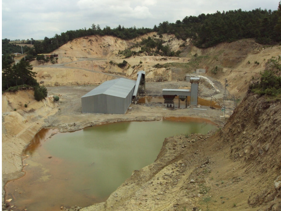
Şekil 116. İşletme faaliyetlerinin sona ermesinden sonra oluşan asit maden göleti (Foto: 29.06.2012).
