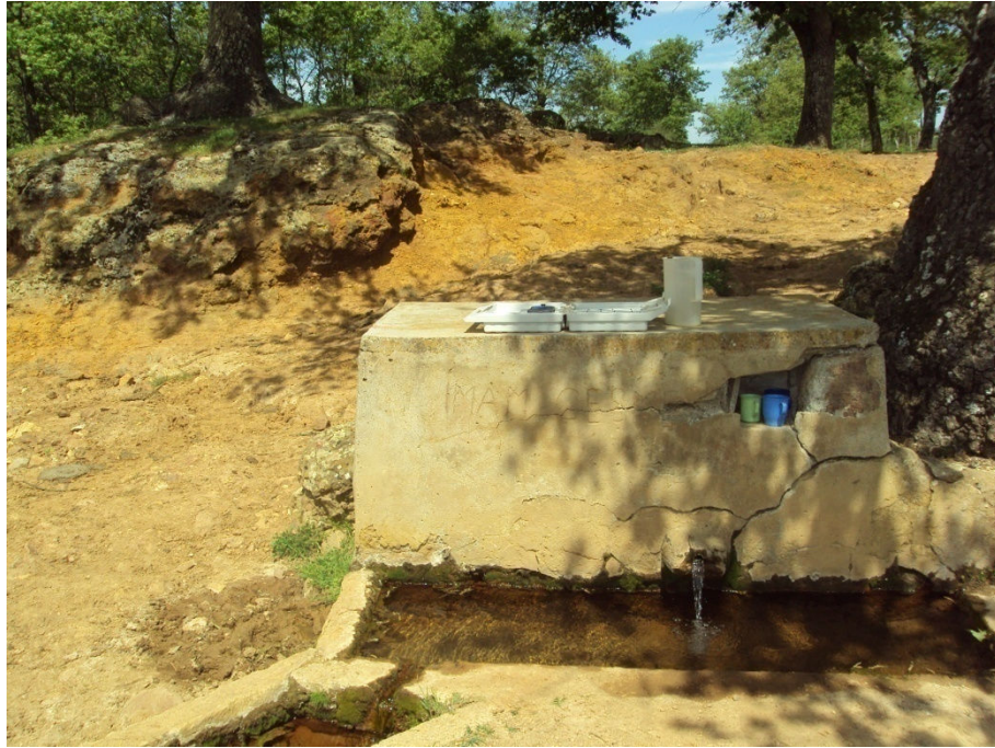
Şekil 145. 21 no'lu su kaynağı.
