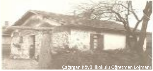
Çağırğan İlkokulu Öğretmen Lojmanı (Yıkıldı) (1)
