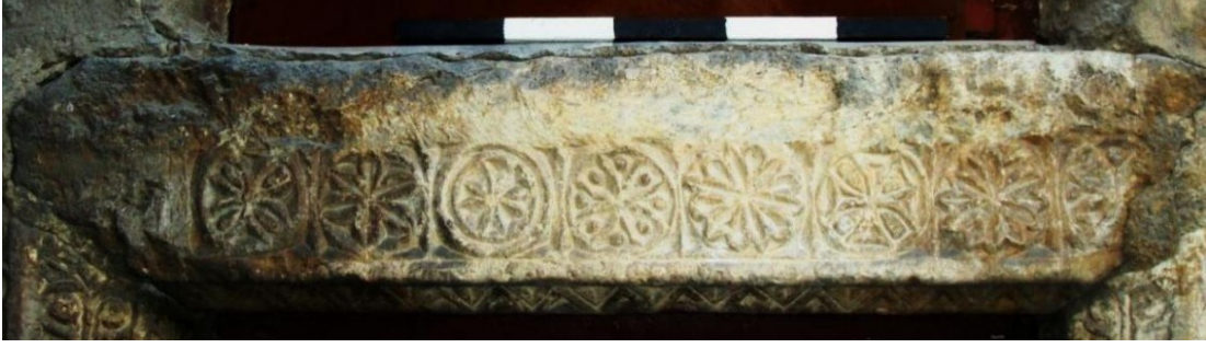
Resim 309. (Kat. No. 220) Tacül Vezir Türbesi doğu cephesi giriş kapısı lento, sarımtırak-beyaz mermer templon arşitravı.
