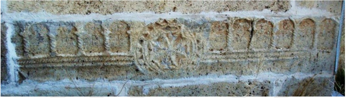
Resim 108. (Kat. No. 19) Zazadin Han doğu cephesi duvar örgüsü, traverten lento üzerinde yer alan rozet motifi.
