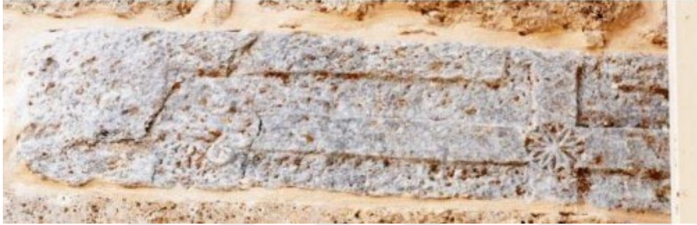
Resim 127. (Kat. No. 38) Zazadin Han kuzey cephesi duvar örgüsü, gri-beyaz mermer levha üzerinde yer alan rozet motifi.
