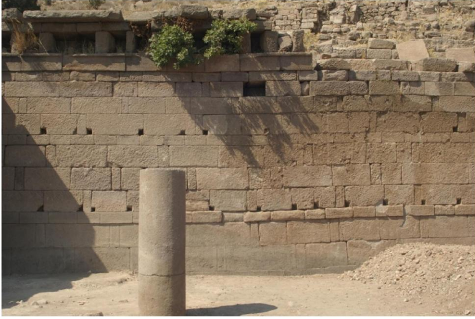
Resim 8: Kuzey Duvarı, Çatı Oyukları
