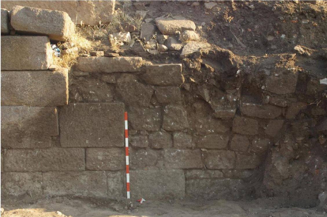
Resim 4: Geç Antik Dönem Stoa duvarındaki tamirat
