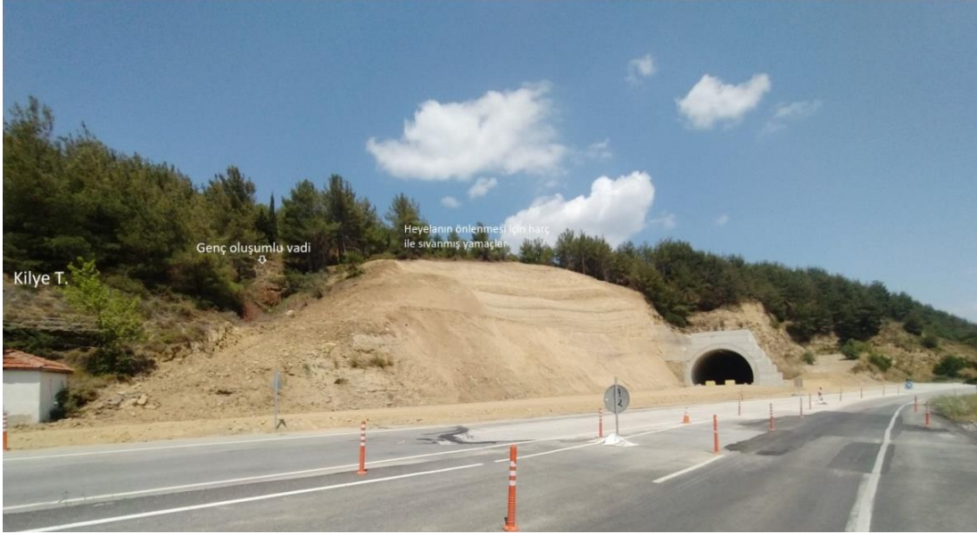
Şekil 55. Kilye Taraçası'nın yol ve tünel yapımı nedeniyle bir kısmı tahrip olmuştur.
