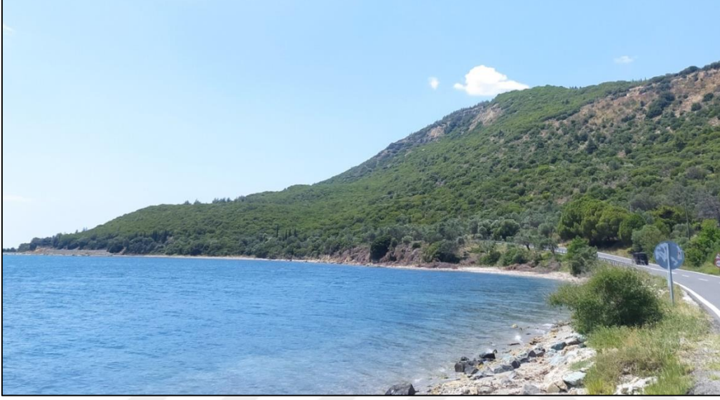
Şekil 36. Havuzlar Mevkiisi yüksek kısımlarda daha önce meydana gelmiş kütle hareketlerinin izleri. Bakış yönü batı.
