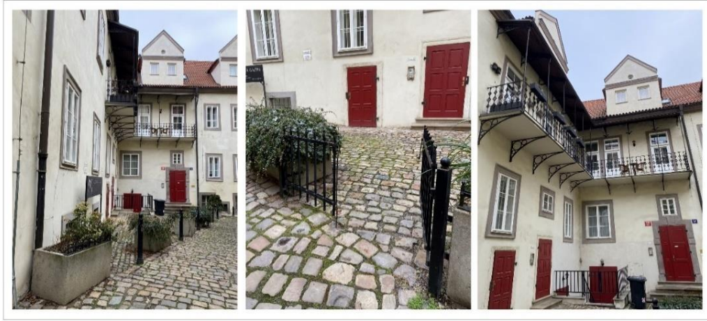
Şekil 62. Sınırlayıcı elemanlar ve dış cephe görünümü (Orijinal, 2021).
