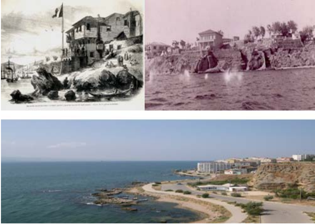
Resim 17: Solda Fener semtinde Fransız konsolosluk binası,1854. 45 Sağda 1960'lı yıllarda doğal haliyle Fener kayahkları, 46 ve altta Fener sahilinin günümüzdeki hali. 47
