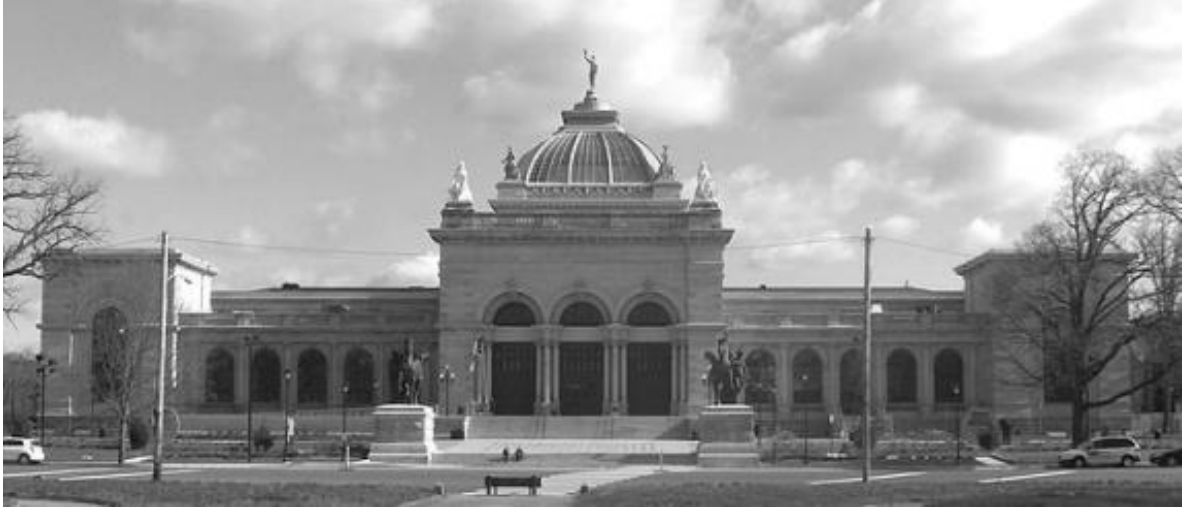
Şekil 43. Güzel Sanatlar Köşkü/Anma Salonu güney giriş cephesi.
