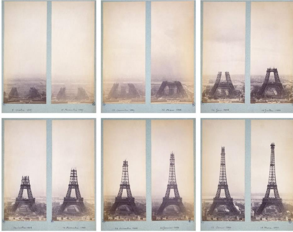
Şekil 55. Eyfel Kulesi yapım aşamaları.
