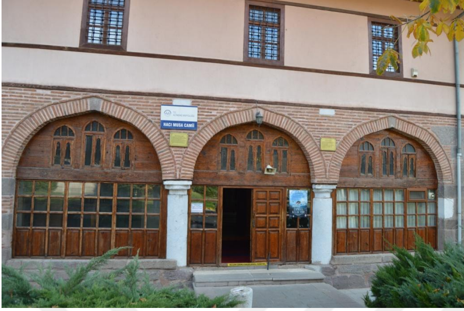
Resim 90: Hacı Musa Camii, Kuzey Cephe.
