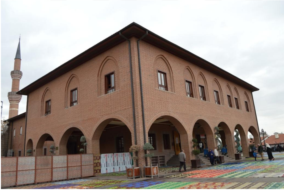
Resim 120: Hacı Bayram Camii, Eklenti Bölümü.
