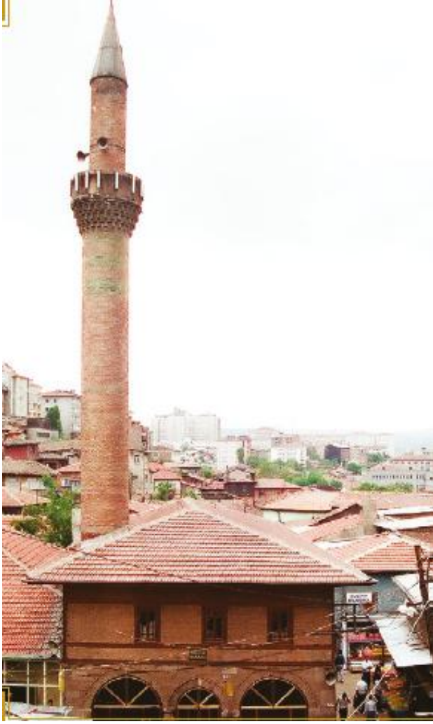
Resim 161: İbadullah Camii Kuzey Cephe (Ankara Vakıf Eserlerinden).
