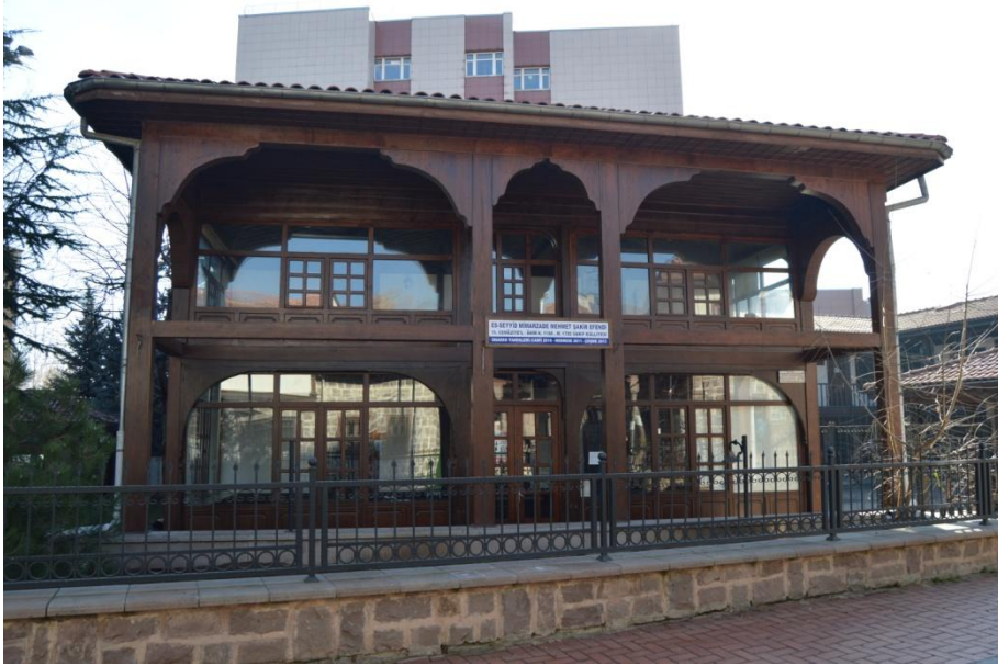
Resim 253: Sarıkadı Camii, Giriş (Kuzey) Cephesi.
