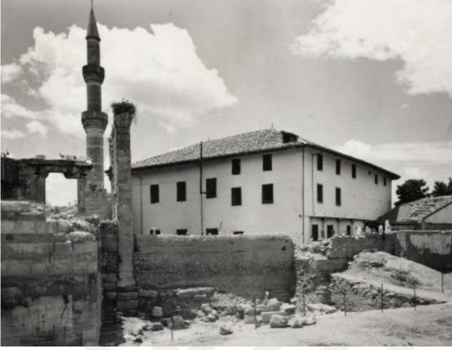
Resim 156: Hacı Bayram Camii Kuzeydoğudan Görünüş, 1940 Yılı Öncesi (VGM Arşivinden Aktaran Bekir Eskici).
