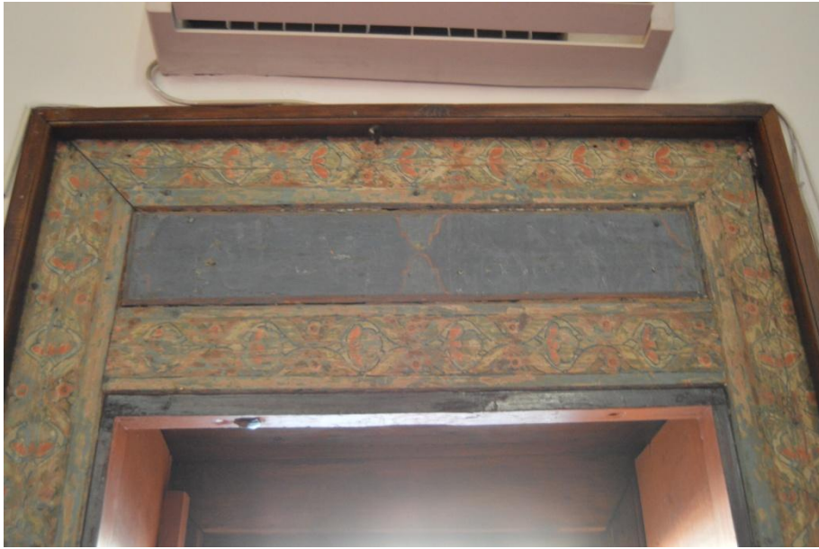
Resim 51: Kağıncıoğlu Camii Doğu Duvarında Bulunan Pencere Pervazlarındaki Süsleme.
