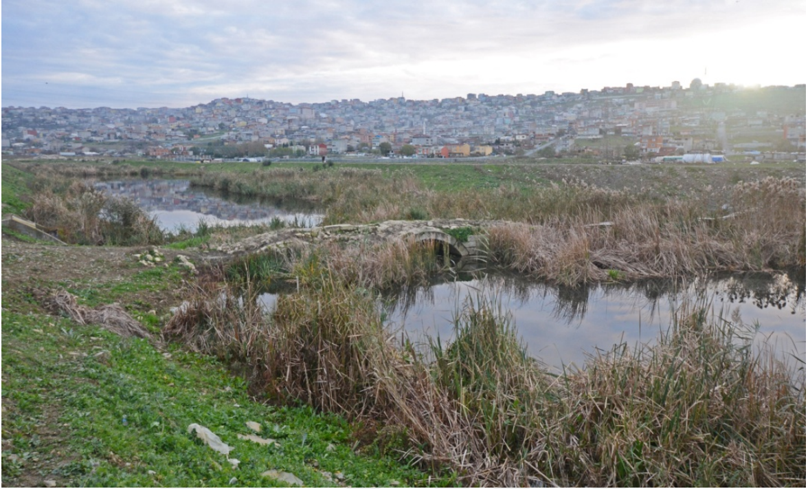
Resim 4.11. Sazlıdere üzerinde bulunan Roma köprüsü. Sazlıdere'nin geniş yatađı resimde görölmektedir. Zaman içinde meydana gelmiş olan alüvyal dolgu ise köprünün “gömölmüş” gibi duran pozisyonundan ortaya çıkmaktadır.
