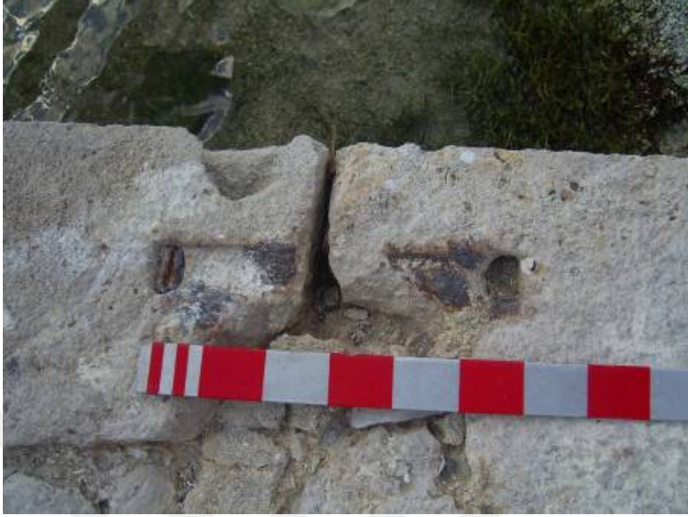
Resim 3.69. Taş iskelenin demir kenet sistemi.
