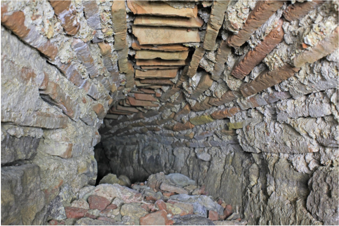
Resim 3.63. Tünelin değişik dönemlerde inşa edildiğini kanıtlayan örgü tekniklerinden tuğla tonoz.
