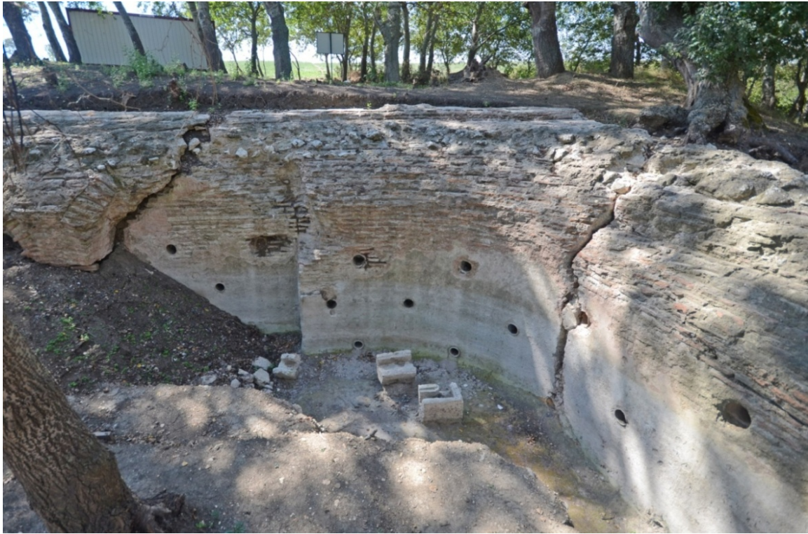
Resim 3.44. Sarnıcın köşesi su basıncını azami kontrol altında tutabilecek gibi tasarlanmış ve arkası kapalı künkler yerleştirilmiştir.
