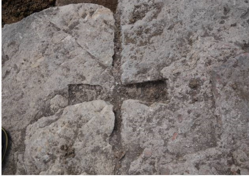
Resim 3.4. Apsis duvarları alt tabakalarından kırlangıç kenet sistemi.
