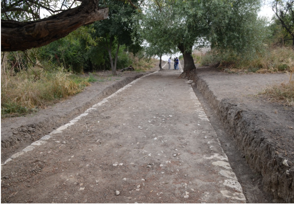
Resim 3.78. Küçük Liman yolu kazı ve onarım sonrası.
