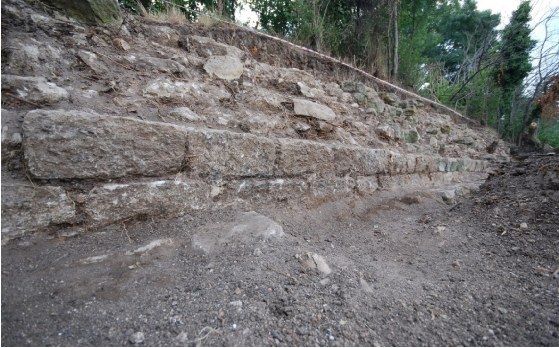
Resim 3.36. Dış sırası düzgün kesme taştan içi harçsız ve içi moloz dolu kıyı duvarları.
