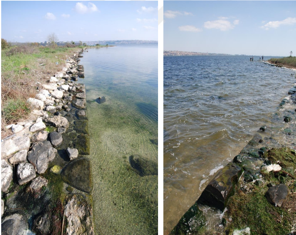
Resim 3.94. Büyük/Bilgili Limanı teras duvarları doğu ve batı yöndeki kalıntıları.
