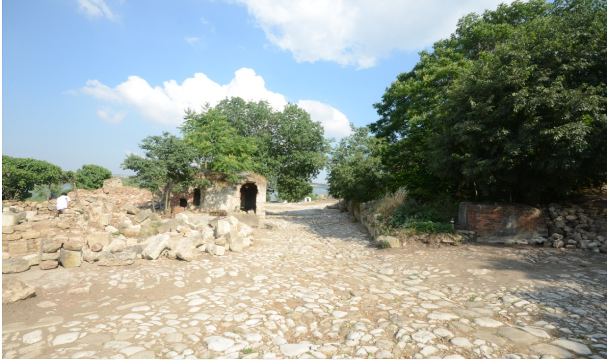
Resim 3.91. Havuzun güney yönündeki yapı kalıntısı ve sonradan eklenen Osmanlı hamamı.
