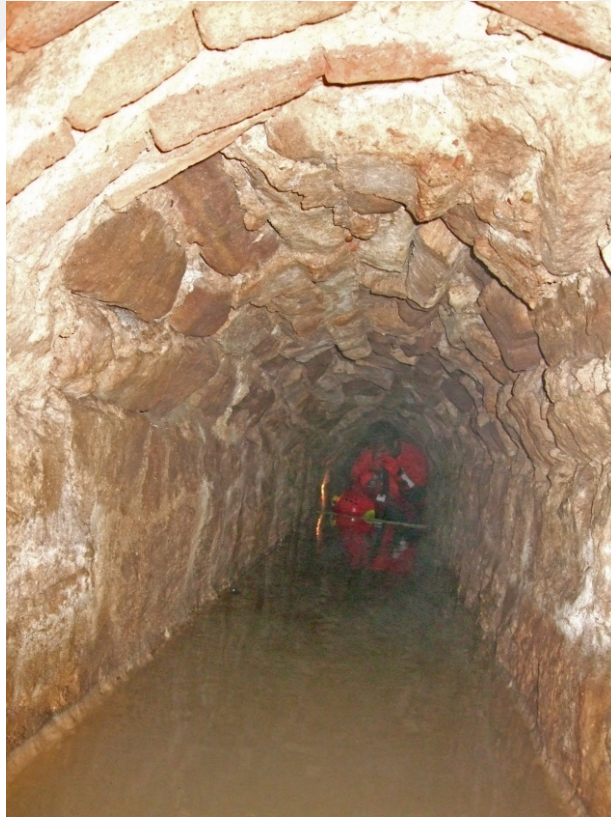
Resim 3.48. Tünelin içindeki tonozlu yapı.
