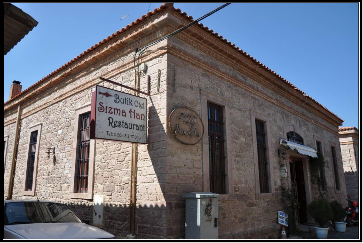
Foto No.80 Atölye Giriş Cephe Düzeni Örneği Genel Görünüm Kat.No 59
