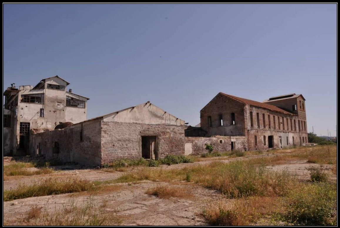
Foto. No: 31 Aynı Avlu İçindeki Fabrikalar Topluluğu (Kırlangıç Fabrikası) (Kat. No: 29-30)
