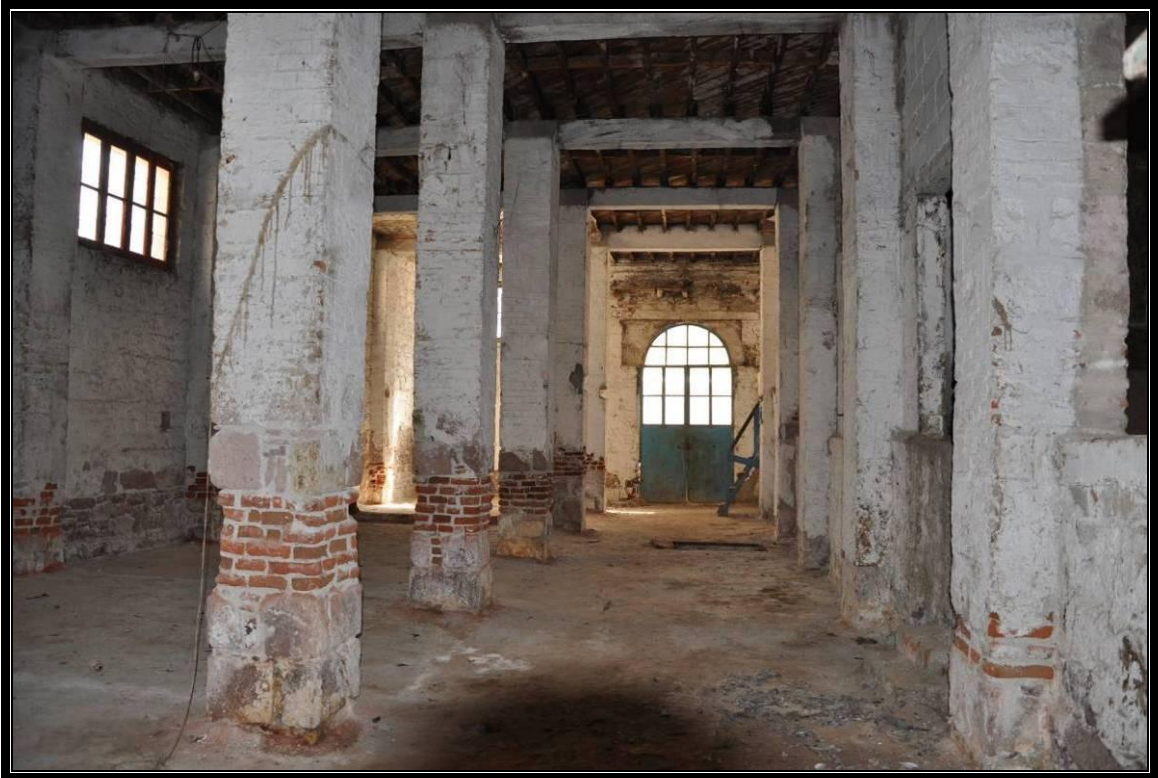
Foto. No: 38 Sabunhane İç Mekân Düzeni Kat.No.18
