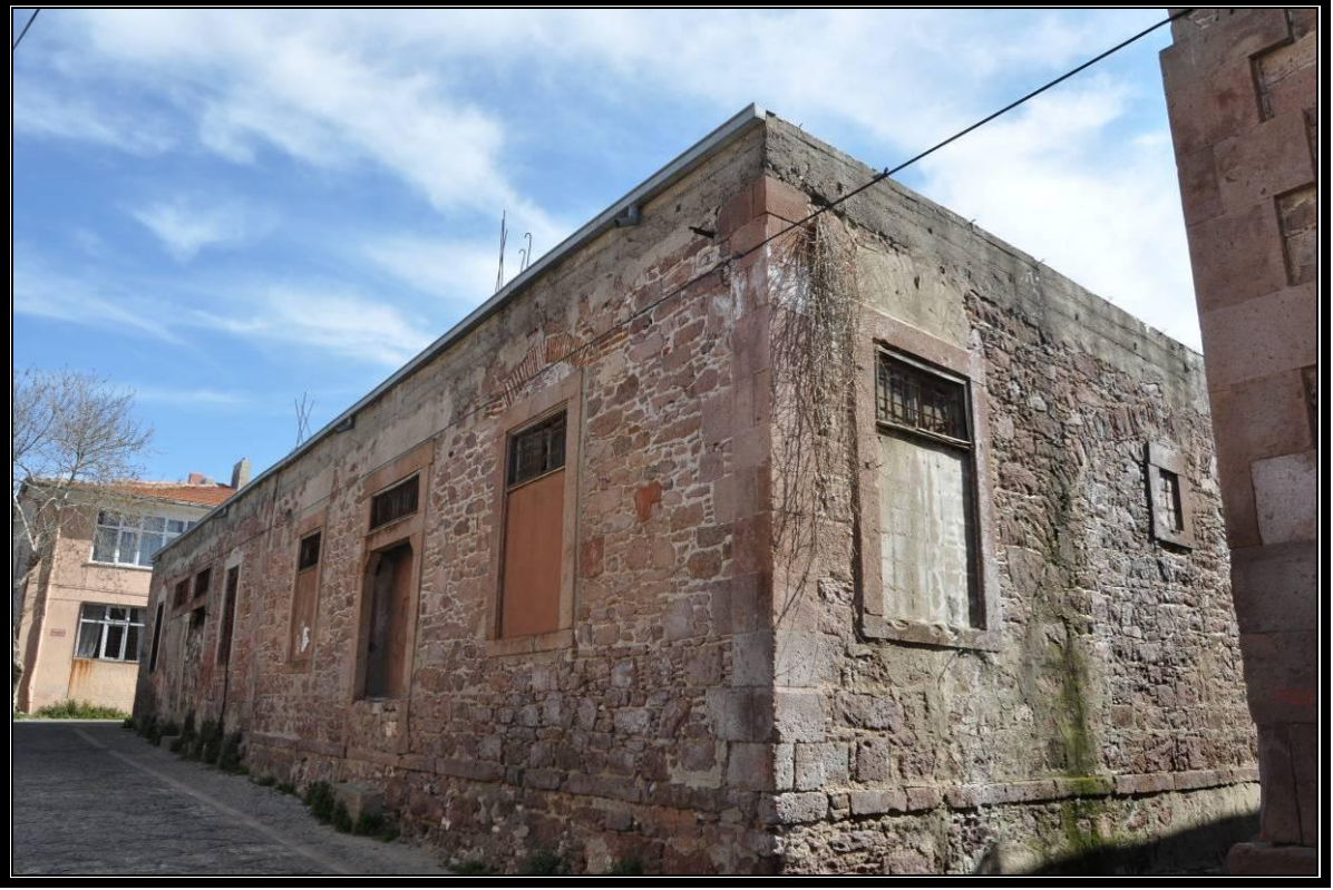
Foto.No: 110 Kaba Yonu Taş Duvar Düzeni
