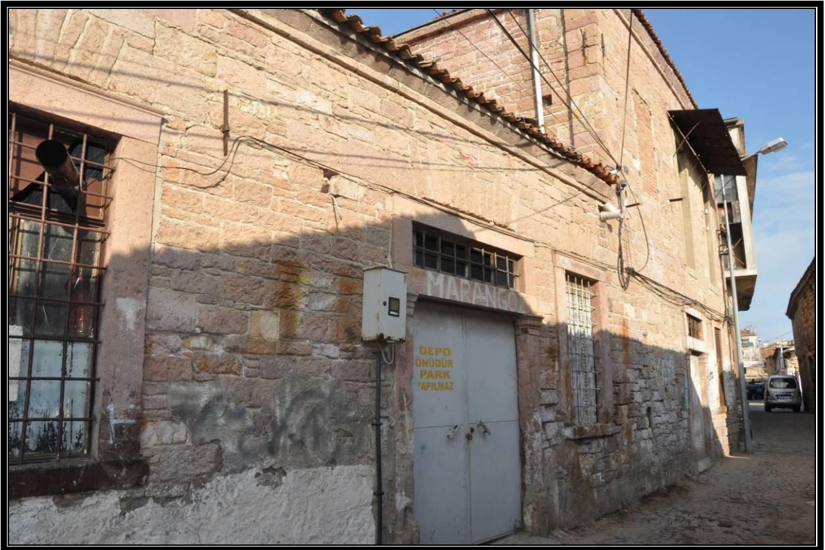
Foto No 83: Depo Arka Cephe Düzen Örneği Kat. No.96
