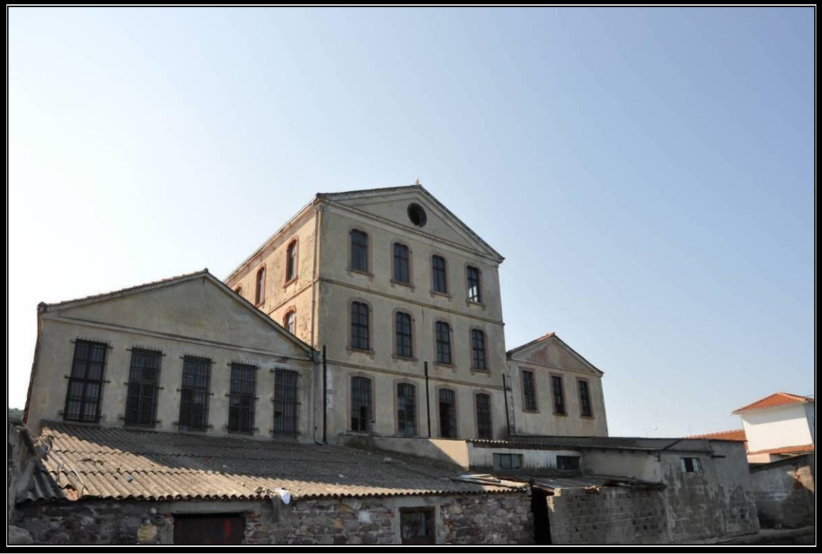
Foto No 70 : Zeytinyağı Fabrikası Arka Cephe Düzen Örneği Kat.No: 28
