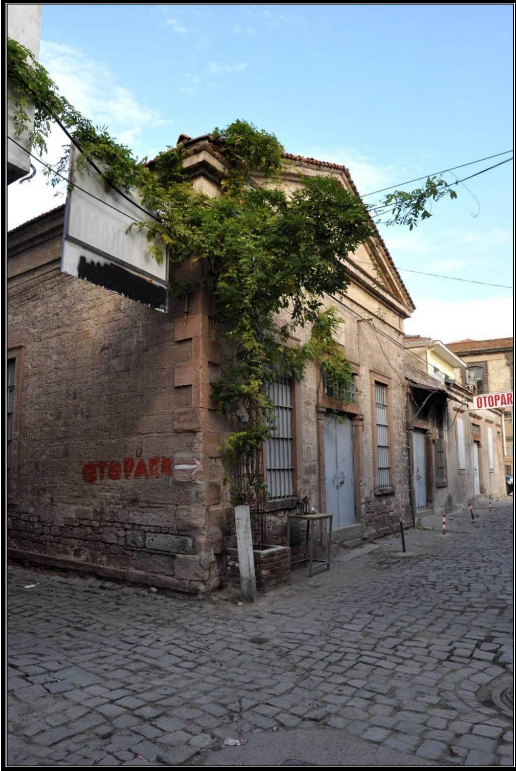
Foto No 48: Tek Katlı Köşe Parsel Atölye Yapısı Kat. No. 45
