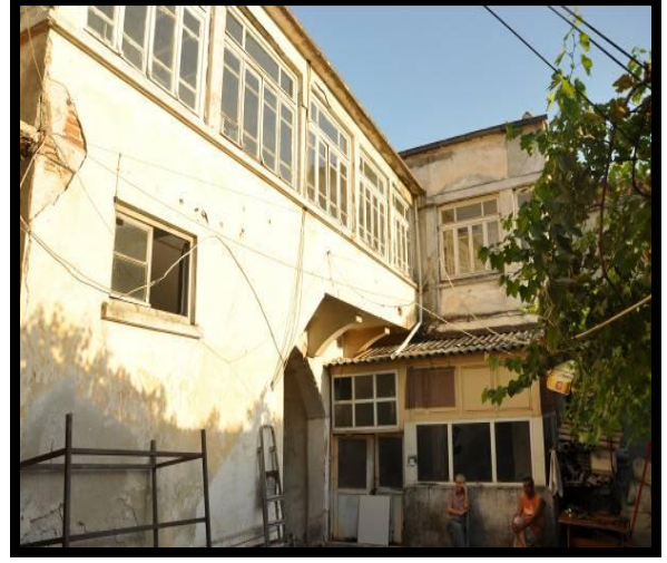
b) İç Avlu ( Batı Cephesi )
