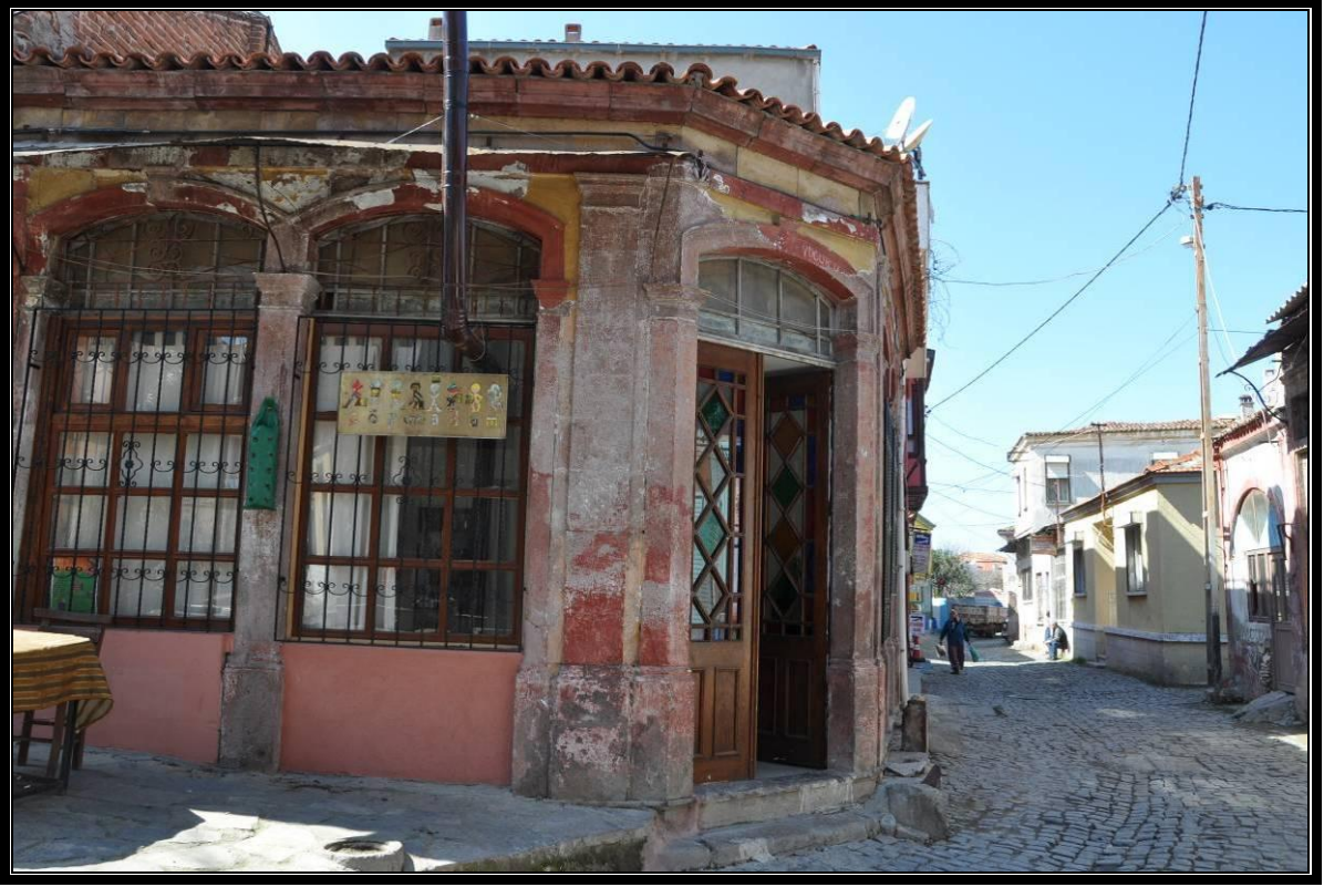
Foto. No 102: Cephelerde Metal Saçak Altı Kuruluşu
