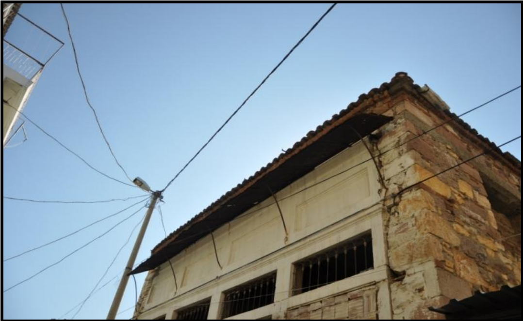
Foto. No 103: Cephelerde Metal Saçak Altı Kuruluşu
