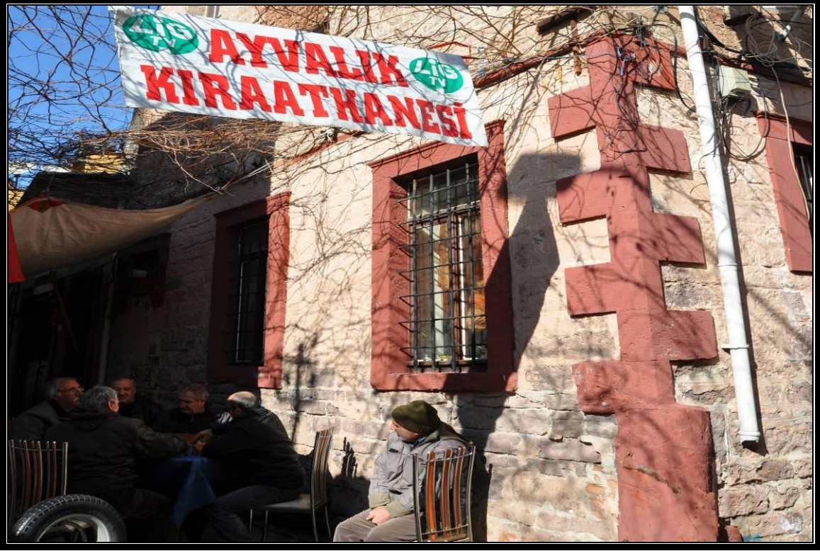
Foto. No 140 : Duvar Köşe Silmeleri Kat.No.8
