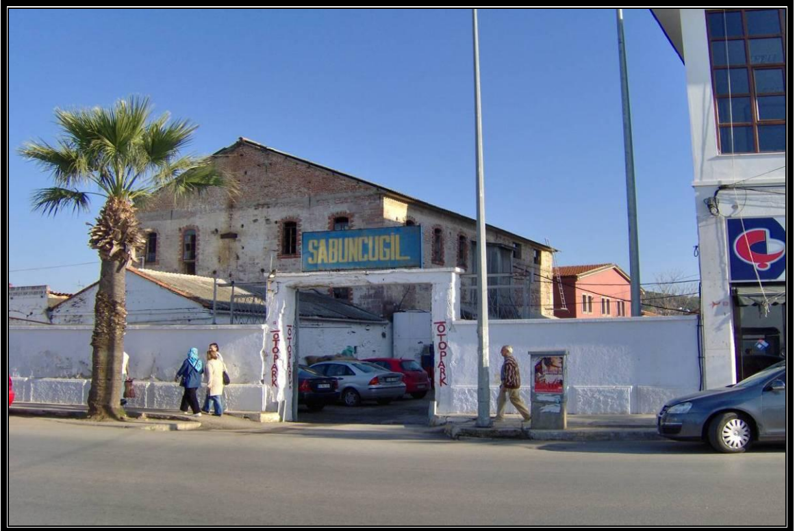
Foto. No: 33 Zeytinyağı Fabrikasının Günümüzdeki Görüntüsü (Kat.No.25)
