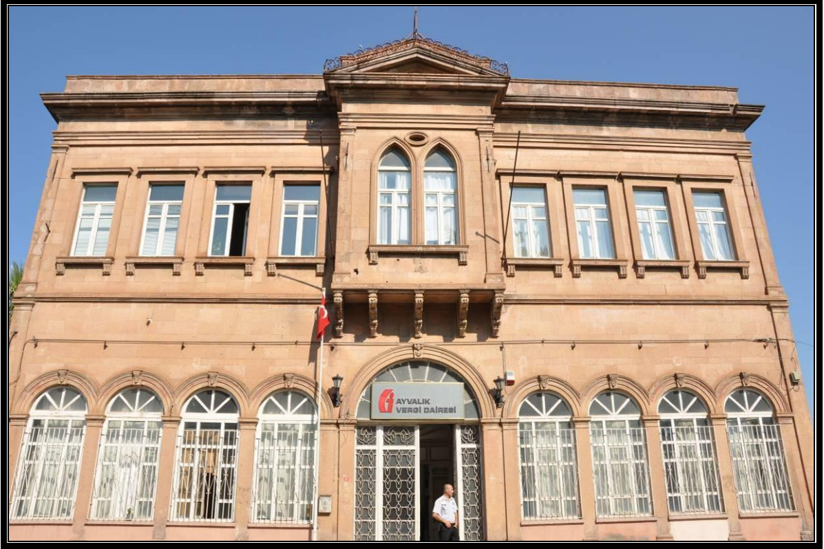
Foto No 88: Konaklama Yapısı Giriş Cephesi Kat No.201
