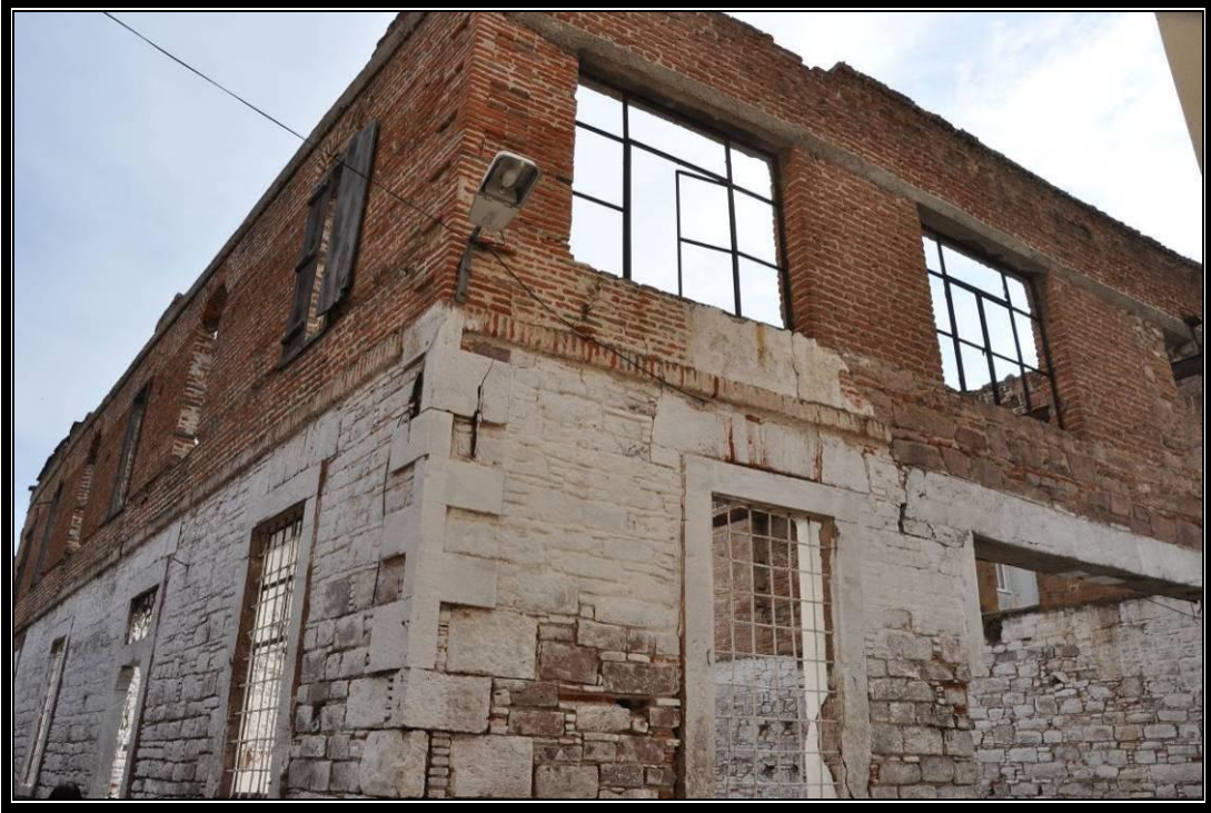
Foto No. 78: Un Fabrikası Cephe Düzeni Kat.No.2
