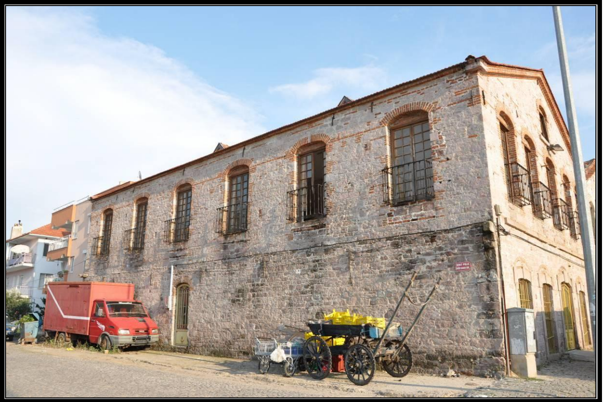
Foto. No 77: Tabakhane Yapısı Yan Cephe Düzeni Kat.No.26
