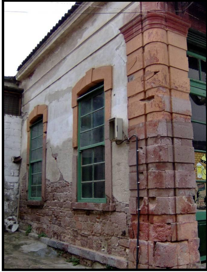
Foto. No 142: Duvar Köşe Silmeleri Kat.No: 177
