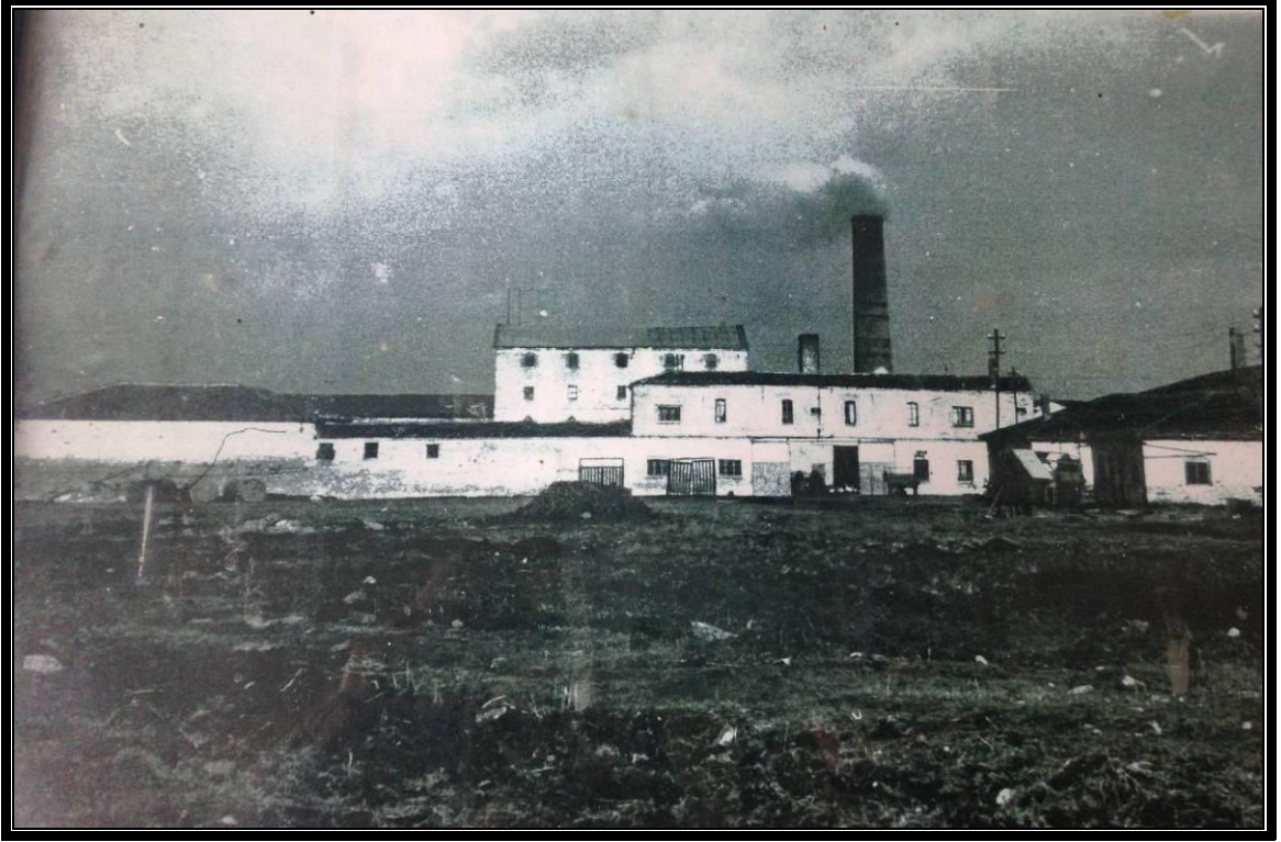
Foto No 28: Gümüşlü Mevkii Fabrika Yapı Topluluğu 1960( Yakup İçten Arşivi)
