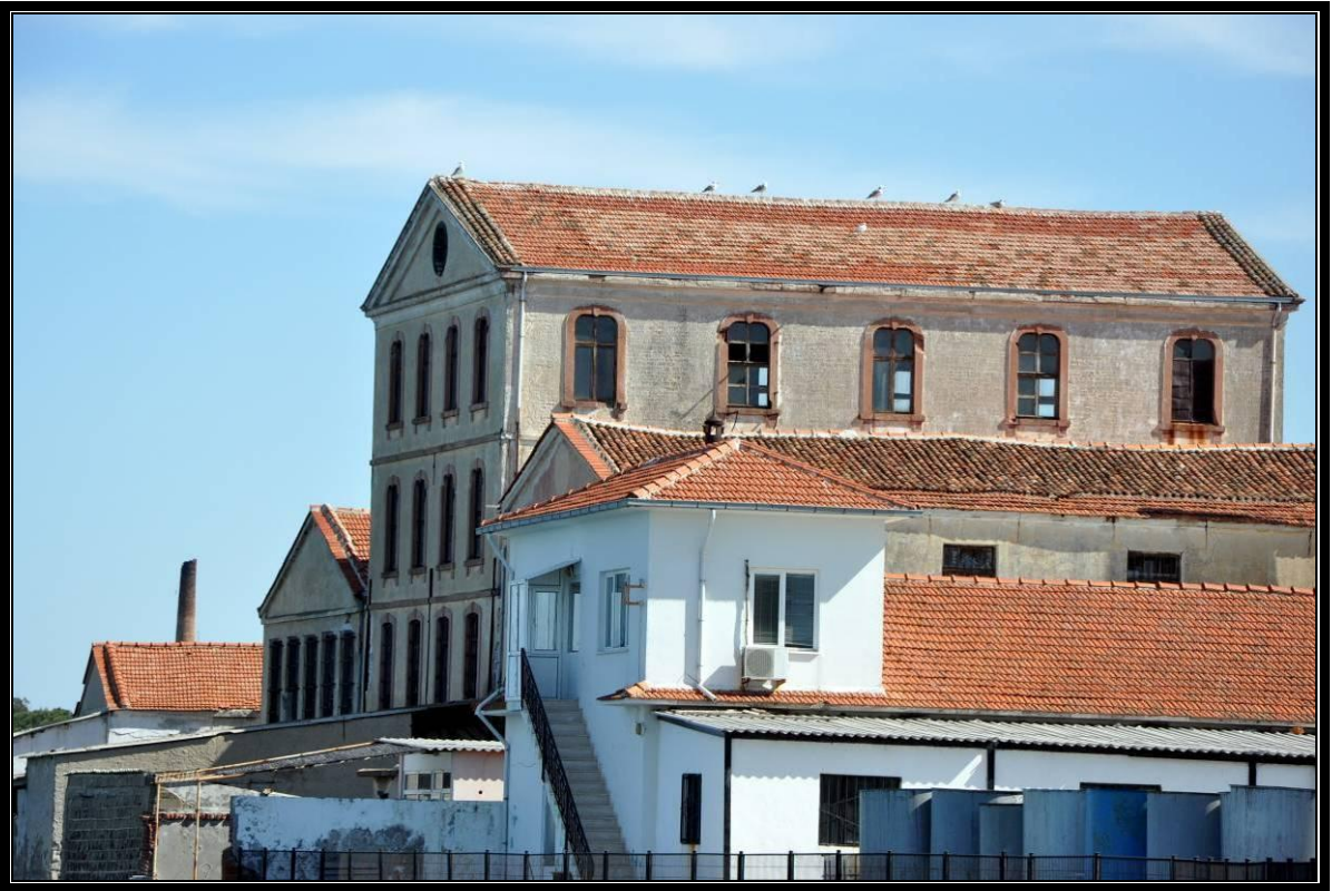
Foto No 119: Kiremit Çatı Örtüleri
