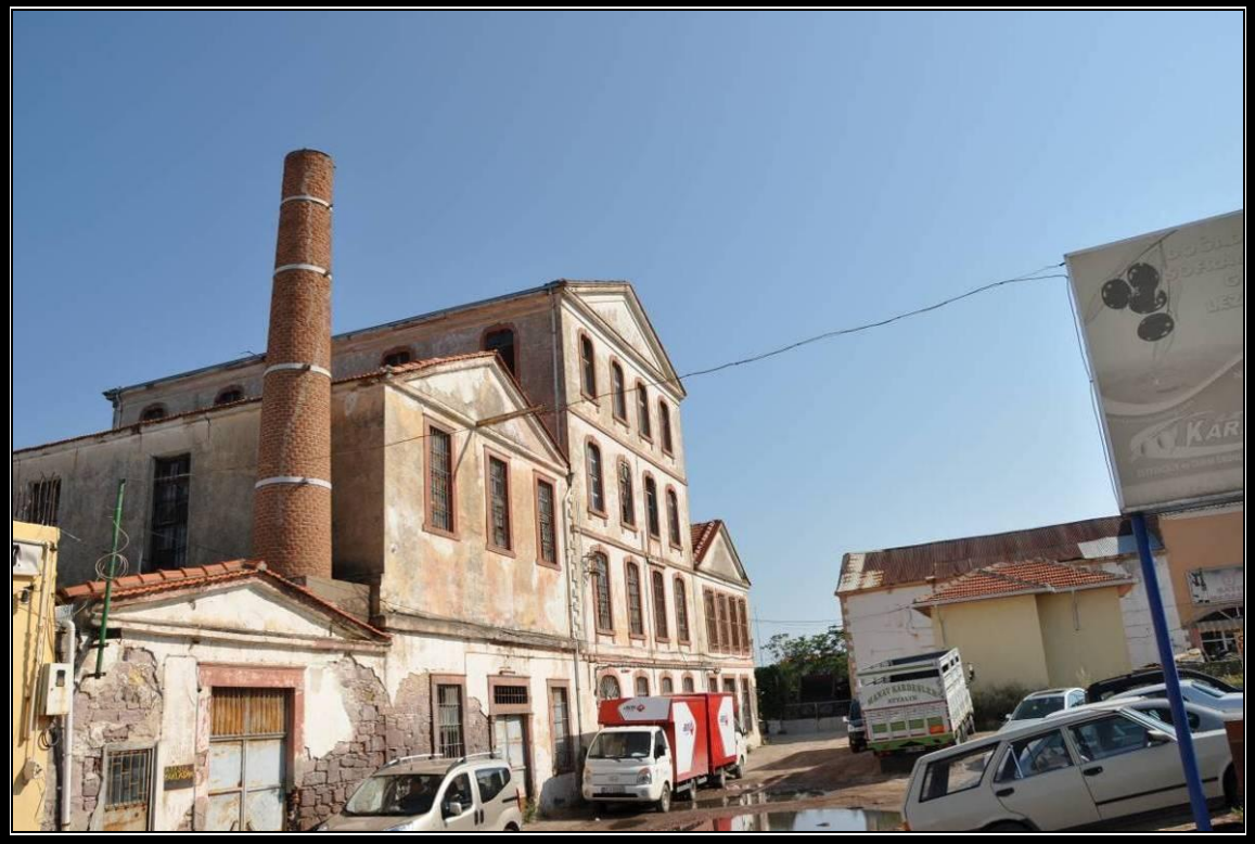
Foto. No: 30: Zeytinyağı Fabrikası Büyük Kompleks Yapı ( Madra Fabrikası) (Kat. No: 25)
