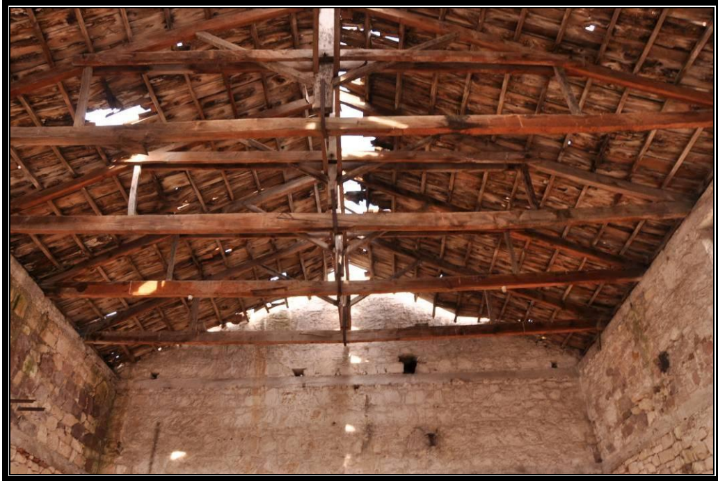
Foto. No 51: Atölye İç Mekân Örtü Sistemi Kat. No. 80
