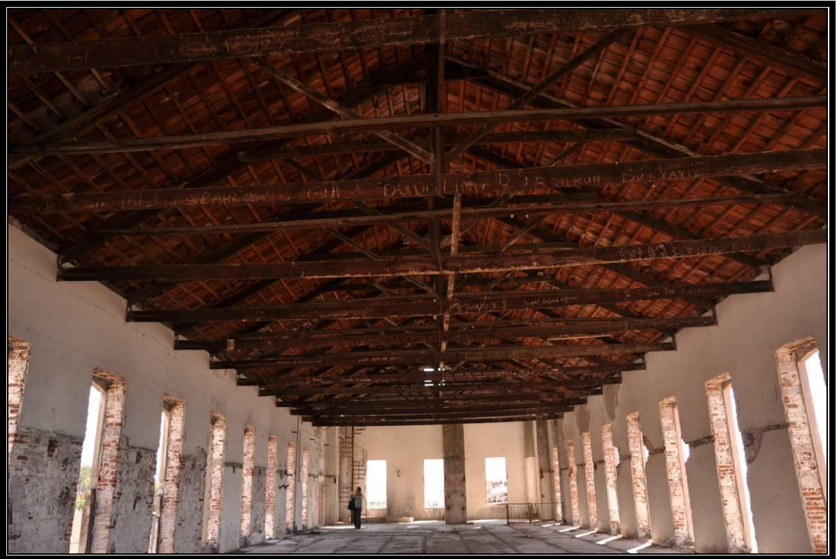
Foto. No 45: Fabrika İç Mekân Örtü Sistemi Kat.No.25
