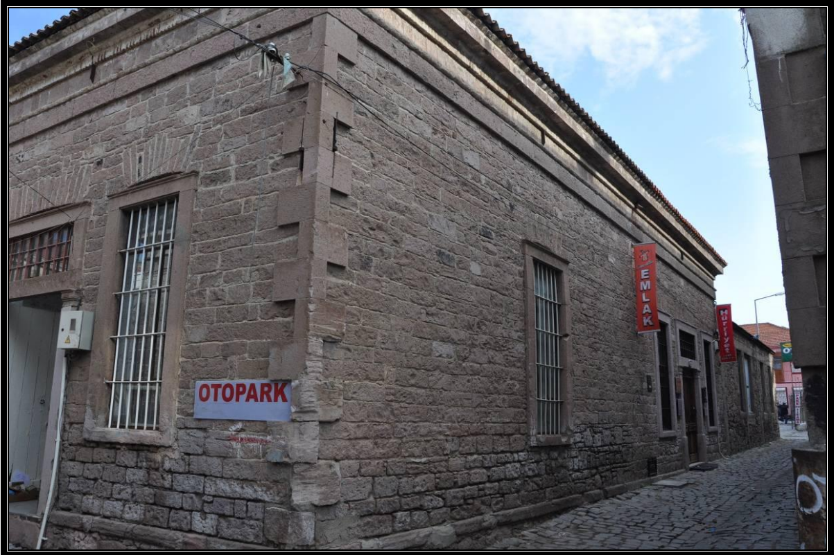
Foto No.81: Atölye Yan Cephe Düzeni Örneği Kat.No 59
