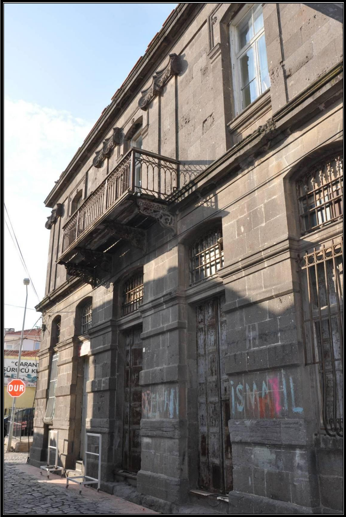
Foto.No 90: Banka Cephe Düzeni Kat No.202
