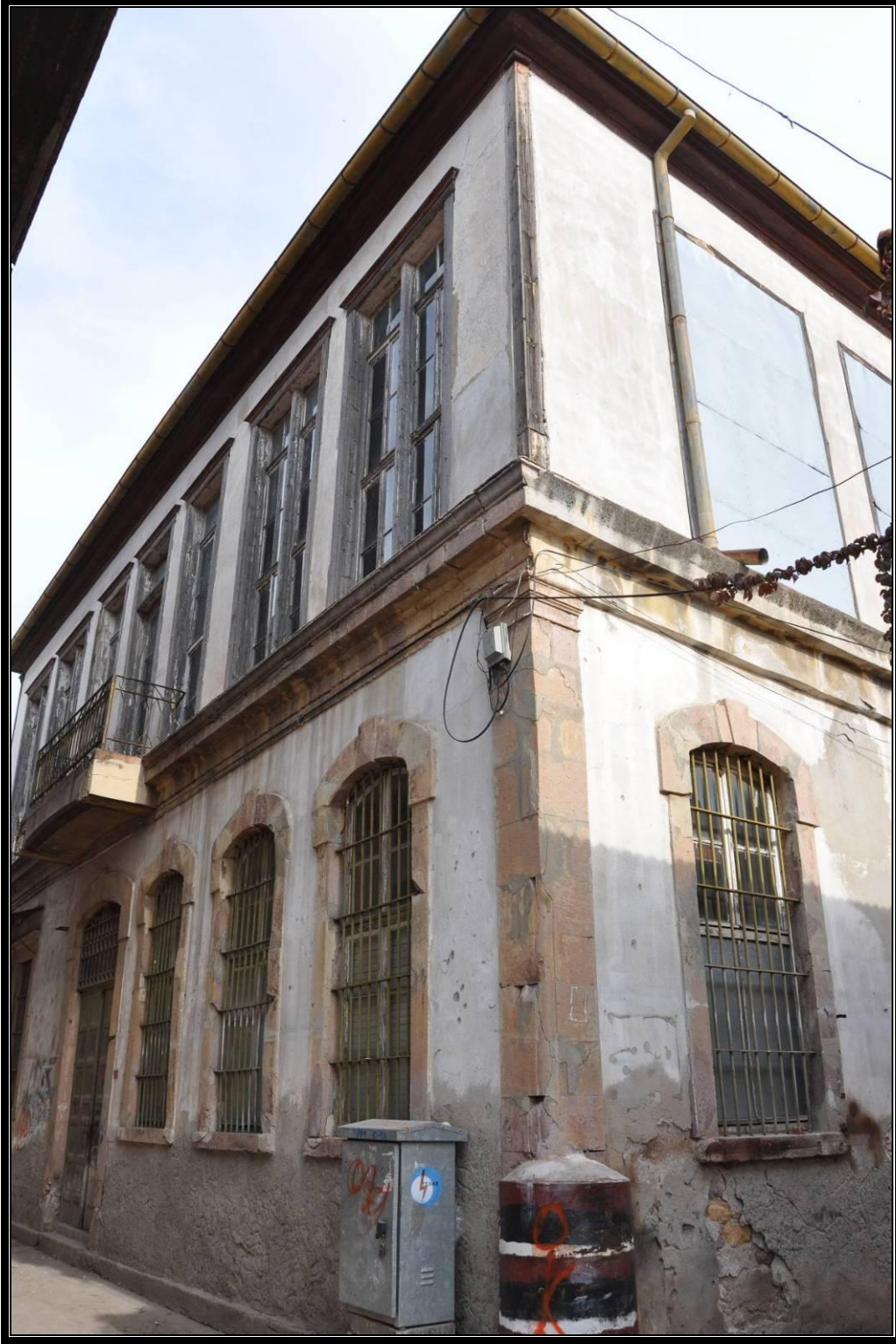
Foto. No 72 : Sabunhane Giriş Cephe Düzeni Kat.No.5 Sabunhane
