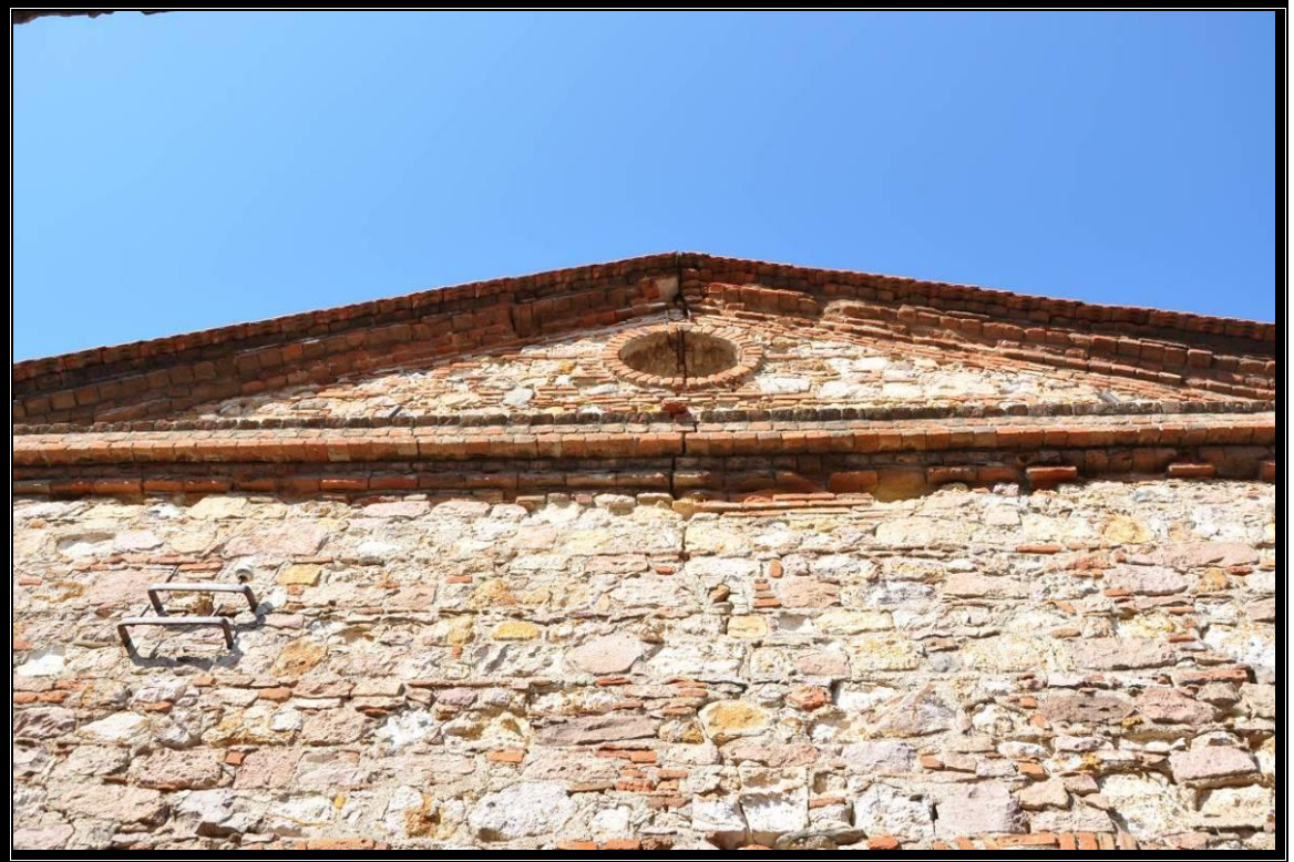
Foto. 105: Cephe Düzeni Saçak Silmesi
