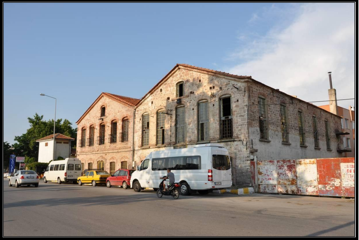
Foto. No 76: Tabakhane Yapısı Giriş Cephe Düzeni Kat.No.26
