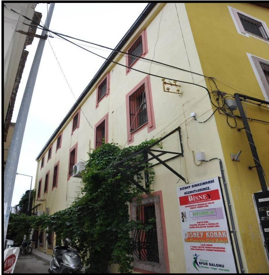
Foto No.79: Un Fabrikası Cephe Düzeni Kat.No.21
