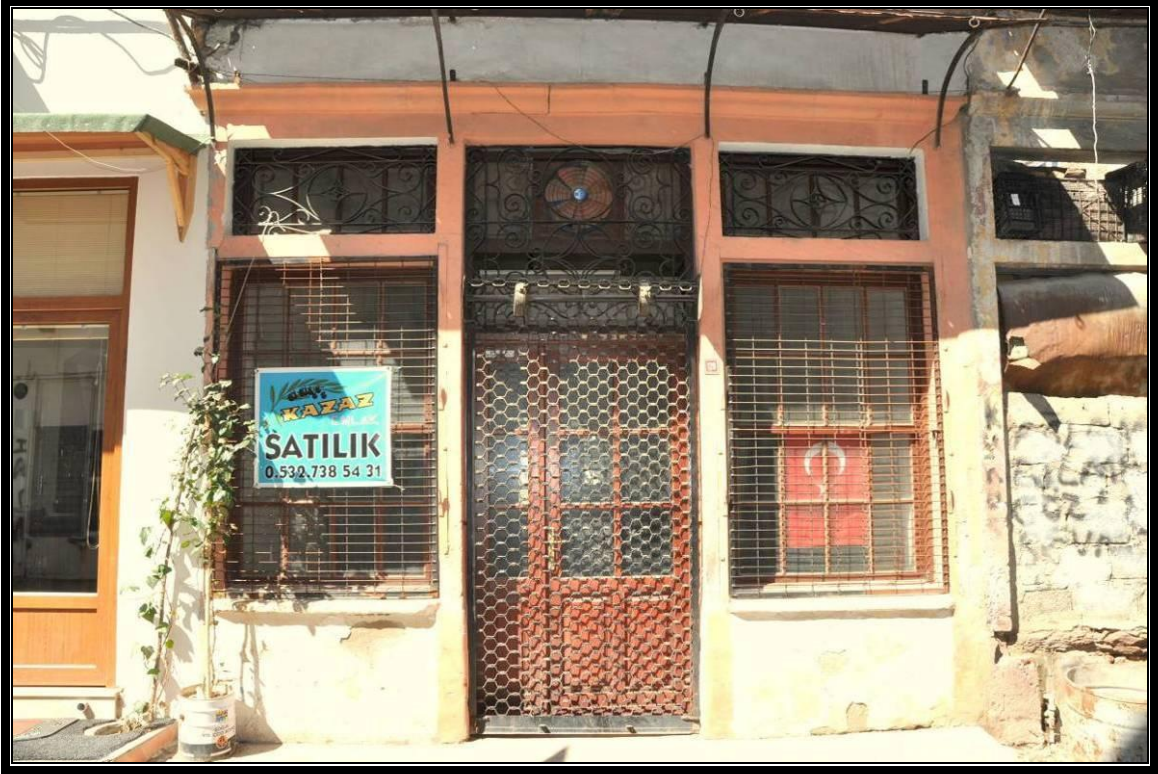
Foto. No 54: Tek Katlı, Tek Yapı Dükkan Örneği (1.A) Kat.No.136
