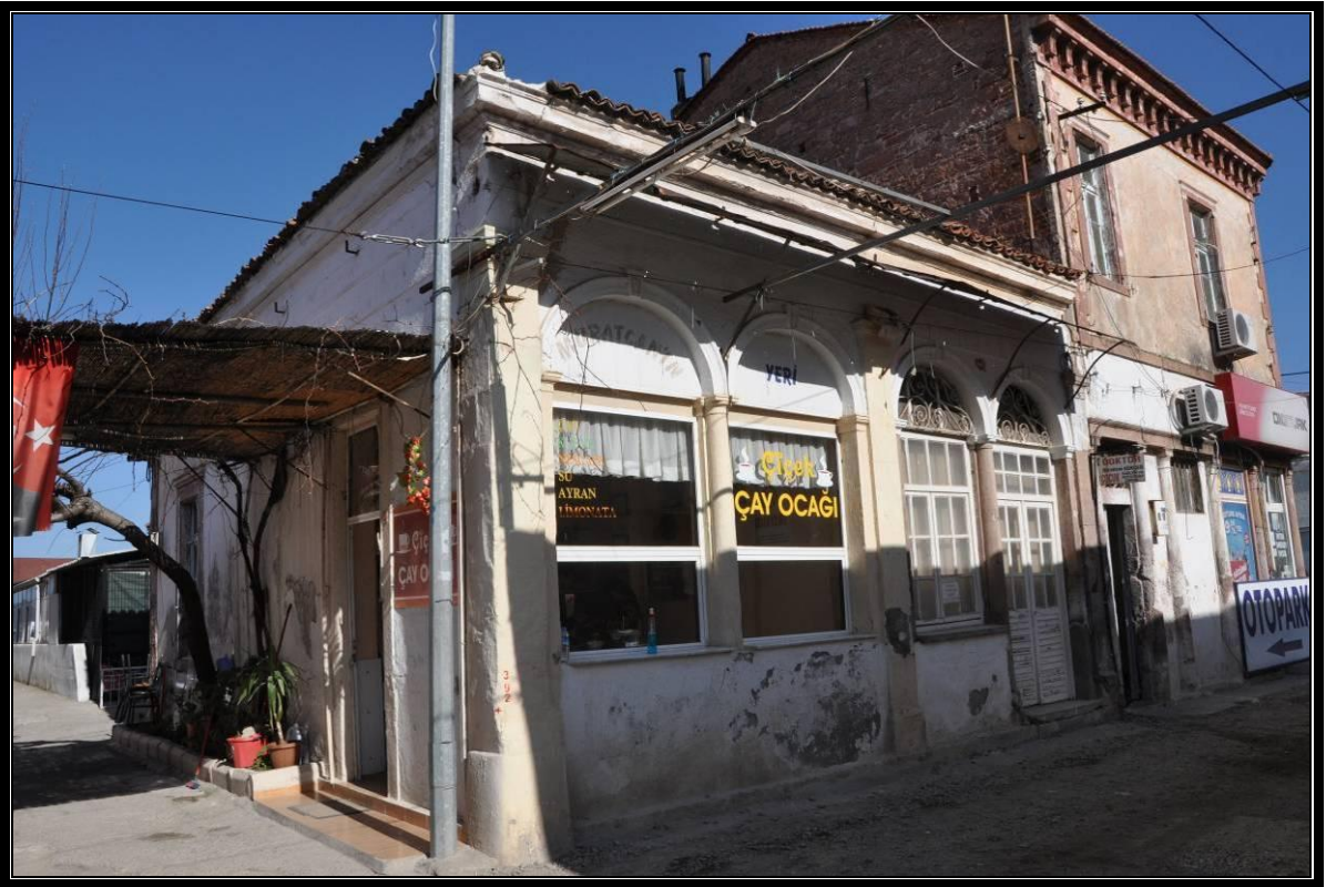
Foto .No 85: Dükkân Giriş ve Yan Cephe Düzeni Örneği Kat No.168
