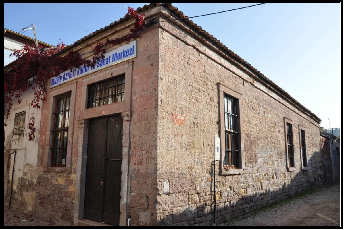
Foto No 82: Depo Giriş ve Yan Cephe Düzeni Örneği Kat. No.93
