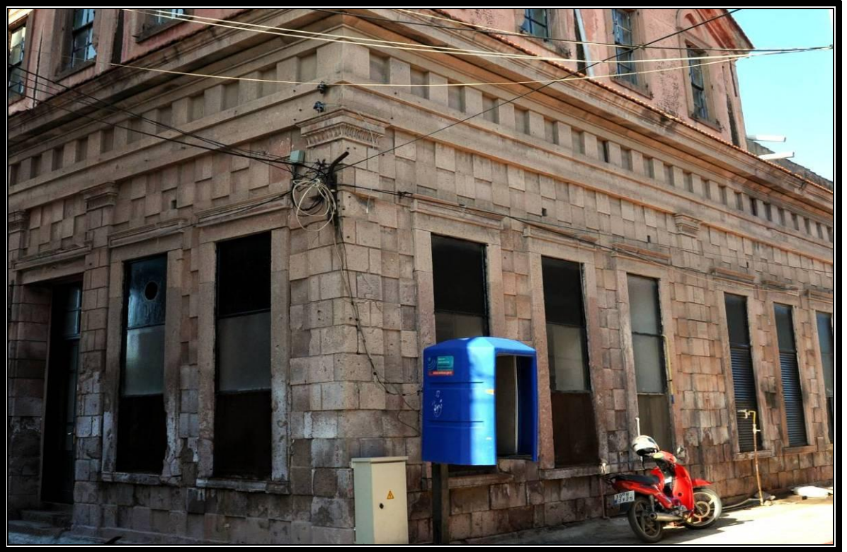
Foto.No: 111 Düzdün Kesme Taş Duvar Düzeni
