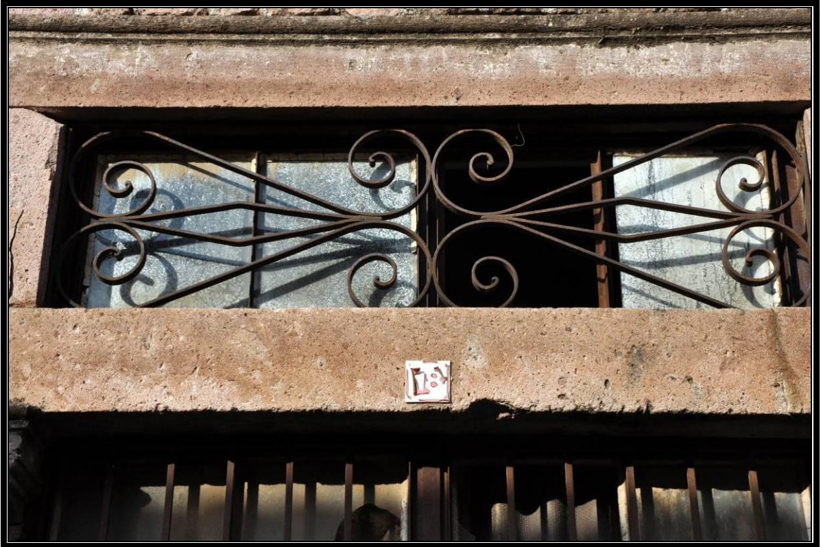
Foto. No 117: Aydınlık Penceresi Demir Örgü Şebeke Örneği
