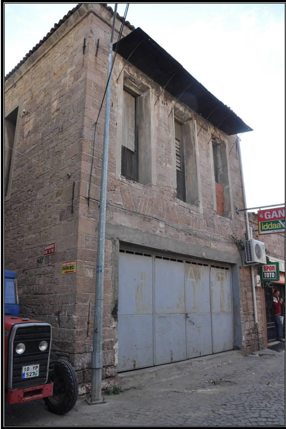
Foto No.34 Sabunhane Yapısı. Kat.No.12
