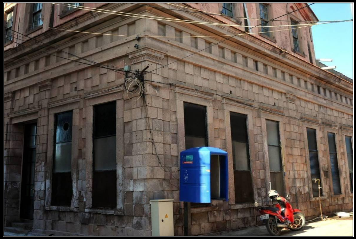
Foto. No 143 : Cephe Yatay Silmeler Kat.No: 192
