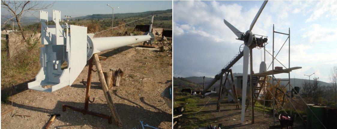
Şekil 4.5. Türbin kule sistemi kanatların bağlanması gösterimi
