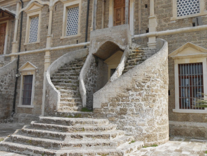
Resim 10. Gelibolu Mevlevîhanesi semâhane-türbe yapısının batı cephesindeki merdiven düzenlemesi
