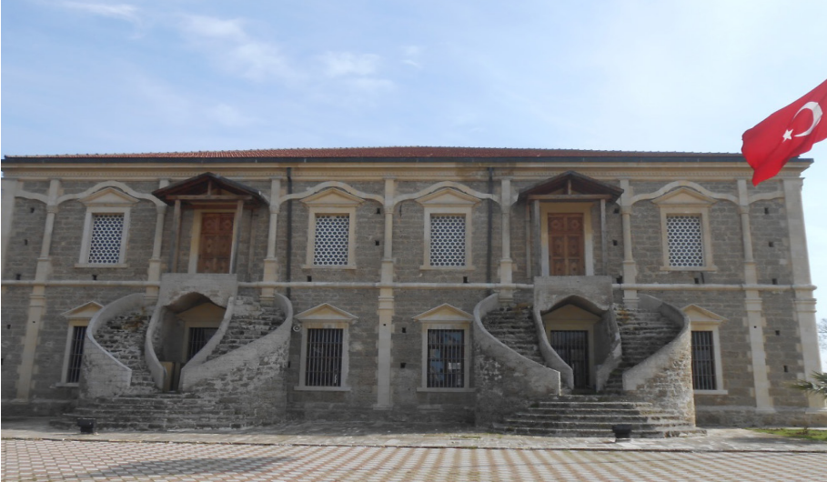
Resim 8. Gelibolu Mevlevihanesi semâhane-türbe yapısının batı cephesi
