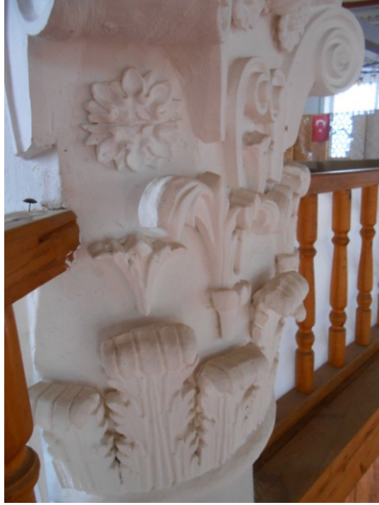
Resim 5. Gelibolu Mevlevîhanesi semâhanede kullanılan korint başlıklı sütunlar
