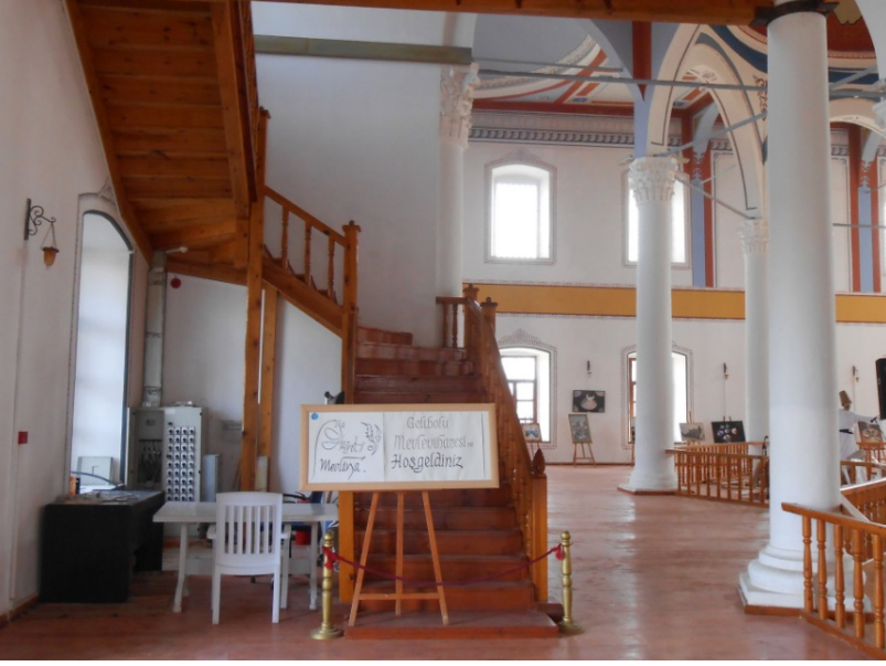
Resim 7. Gelibolu Mevlevîhanesi semâhane-türbe yapısının üst kat mahfile çıkan merdivenleri
