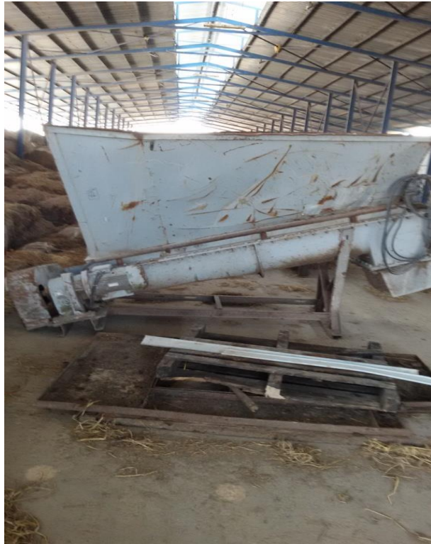
Şekil 1.8. Atık Hazırlama Ünitesi (Gönen-Temmuz 2015)
