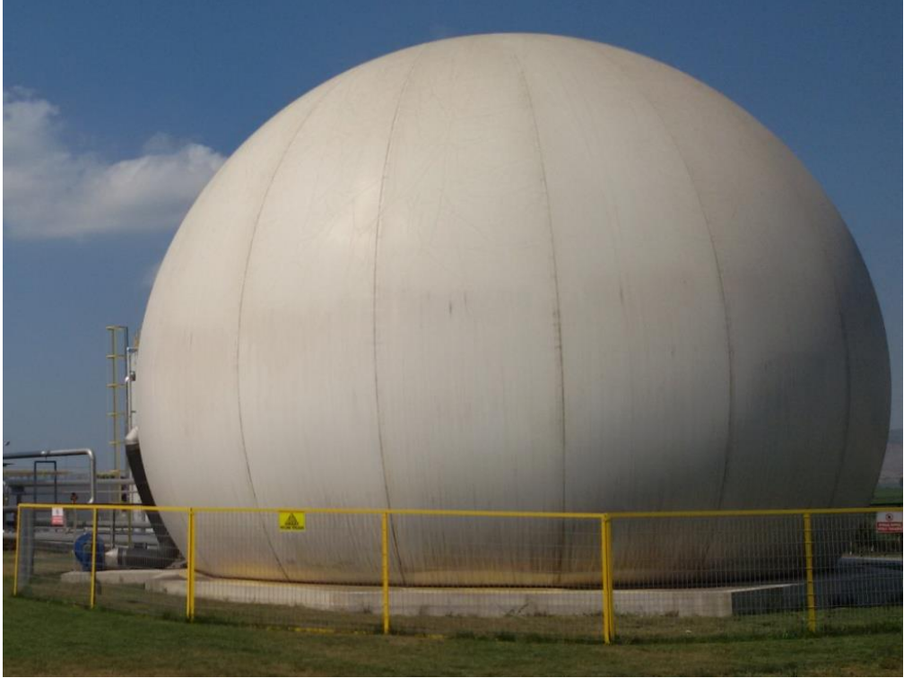
Şekil 1.11. Elde Edilen Biyogazın Saklandığı Depo (Gönen- Temmuz 2015)
